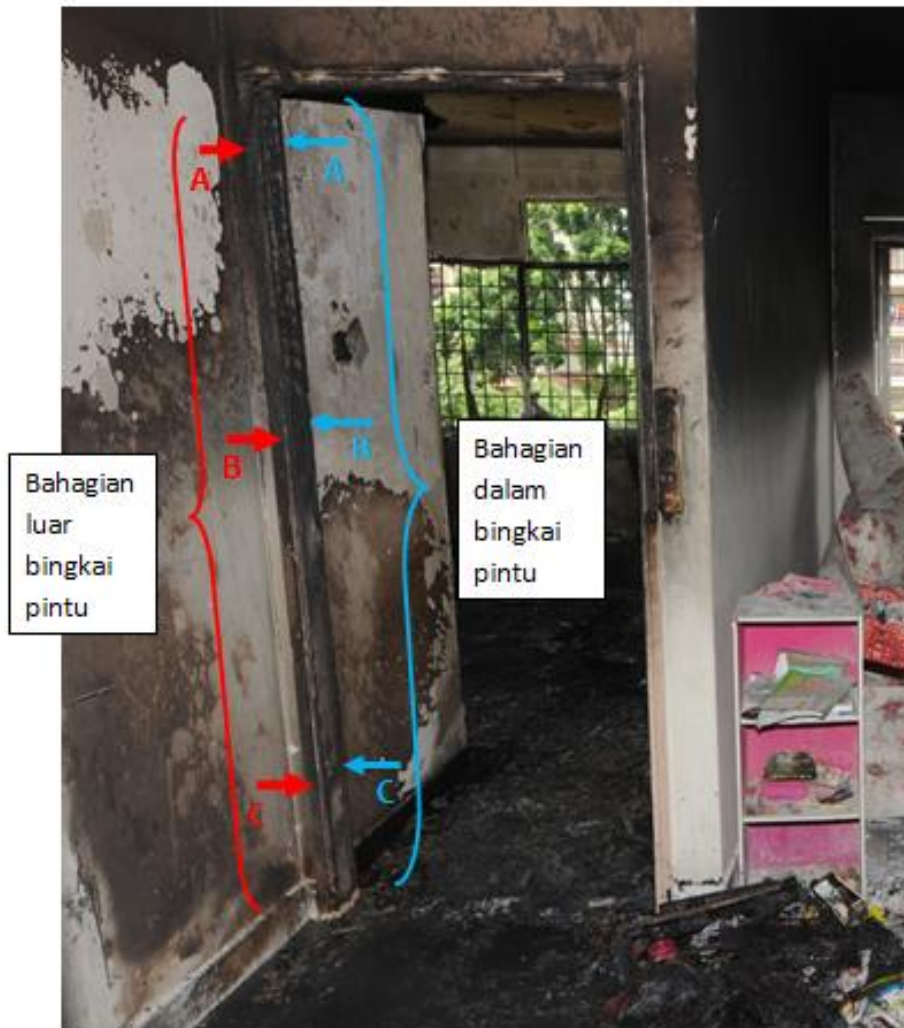
Gambar 7 : Kesan char yang terhasil di bahagian dalam dan bahagian luar bingkai pintu Bilik No.1.
