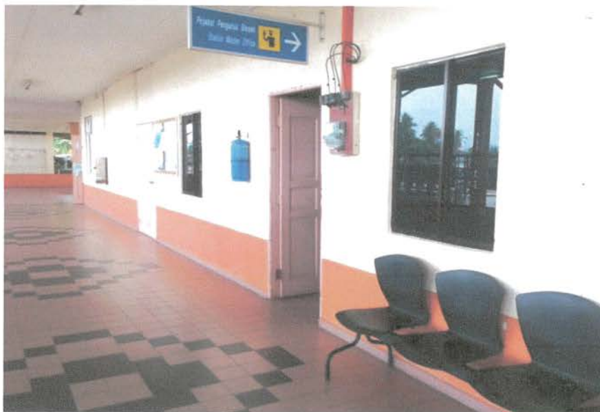
Foto 1: Bangunan Stesen KTMB Kuala Krai dan Platform
