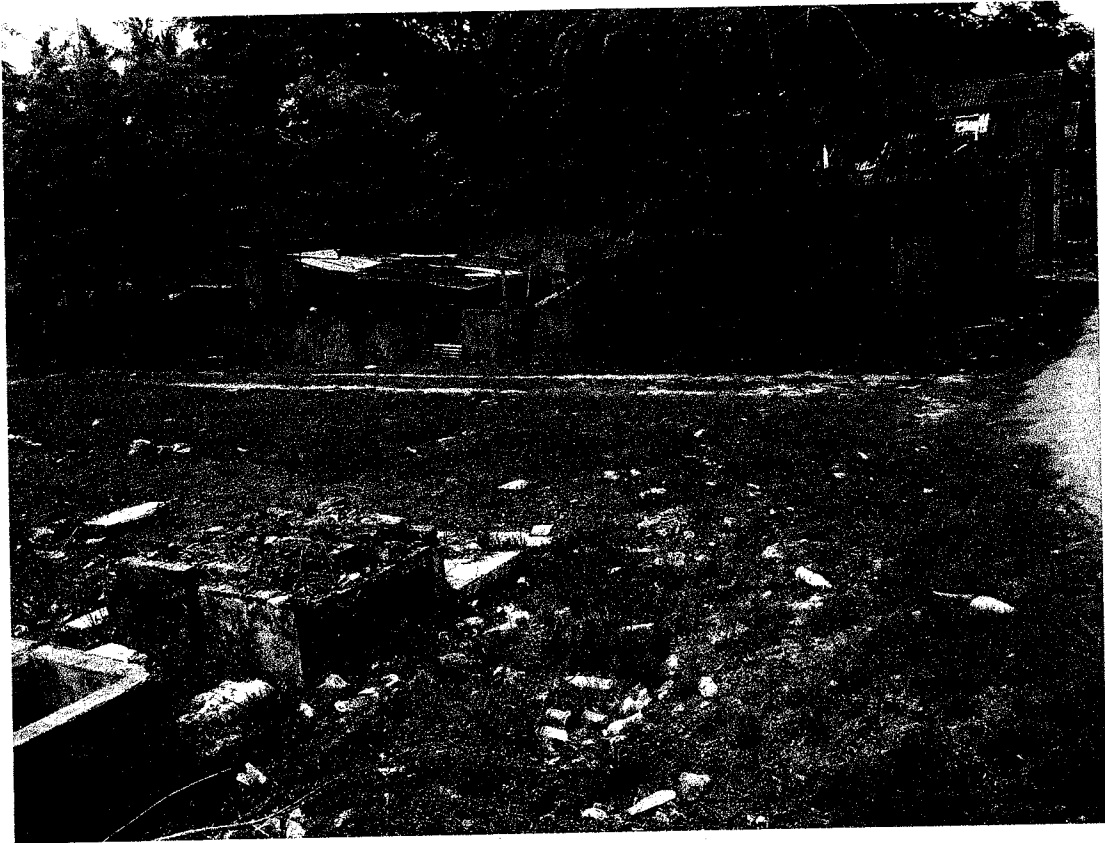
Foto 10: Lokasi Tapak Pembinaan 9 Unit Kuarters Baharu
