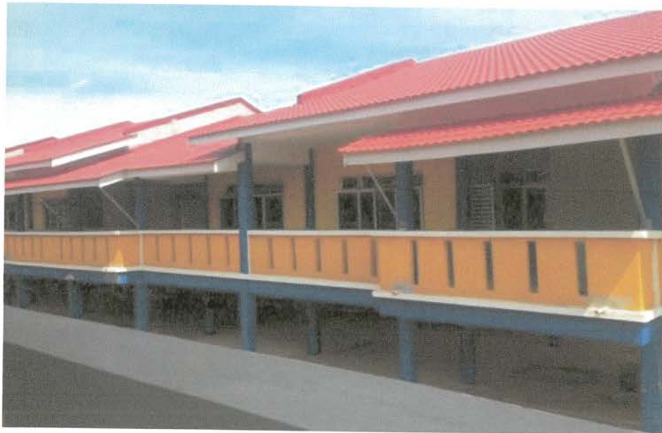
Foto 22: Bangunan 9 Unit Kuarters Baharu
