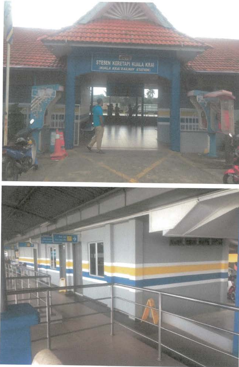
Foto 13: Bangunan Stesen KTMB Kuala Krai dan Platform
