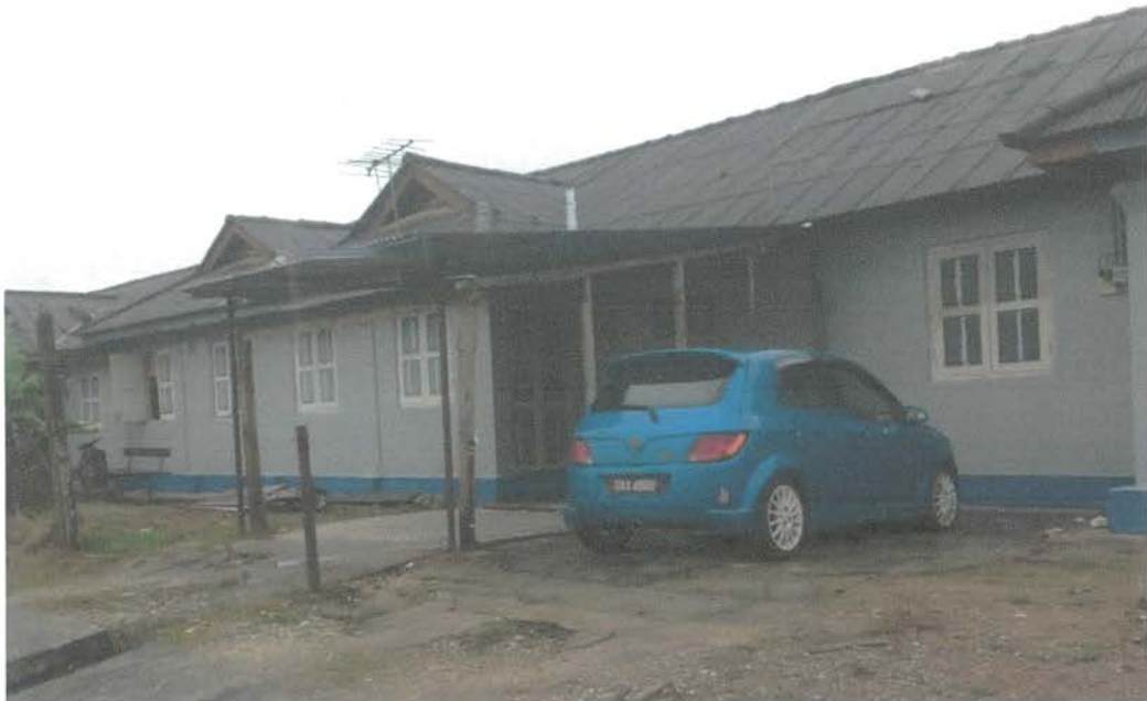
Foto 21: Bangunan Kuarters KTMB Sedia ada
