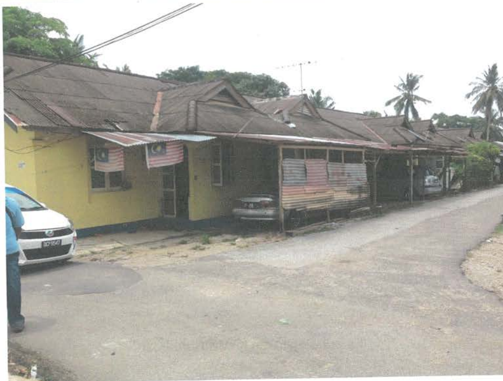
Foto 9: Bangunan Kuarters KTMB Sedia ada
