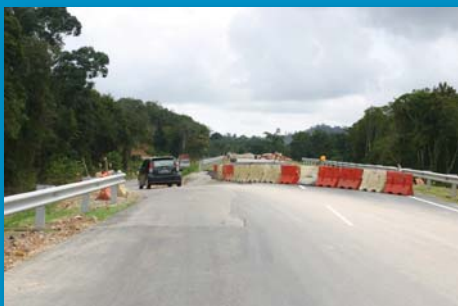
Tiada papan tanda di lencongan ini. Juga tiada 'delinicator'. Hanya sebuah 'blinker' bagi membantu pengguna jalanraya di waktu malam.
