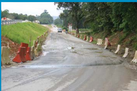
Permukaan jalan di laluan lencongan trafik yang tidak disenggara dengan baik. Susunan 'barrier' yang tidak teratur dan tiada 'delineator'.
