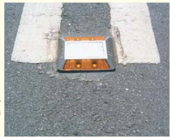
Plate 4: Pemasangan 'road stud' pada garisan tengah jalan, memberi panduan kepada pemandu pada waktu malam.
