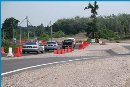
Susunan 'barrier' yang tidak teratur, malah ada yang terbalik (tidak diisi air/pasir?). 'Delineator' juga tidak digunakan.
