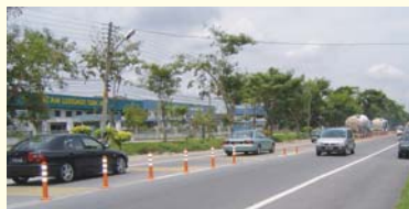
Plate 2: Memasang 'flexible post' pada pertengahan jalan bagi menghalang kenderaan memotong atau menghalang kenderaan keluar dari simpang serta mengganggu kenderaan di laluan utama.
