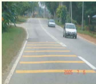
Plate 4: Pemasangan 'road stud' pada garisan tengah jalan, memberi panduan kepada pemandu pada waktu malam.
