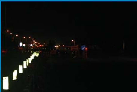
Pantulan cahaya yang baik dari 'delineator' tetapi tidak dari papan tanda lencongan di hadapan.
