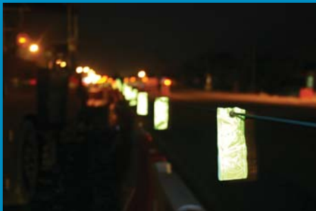
Pantulan cahaya yang baik dari 'delineator' di atas di waktu malam.
