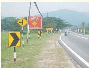
Plate 1: Memasang papan tanda amaran dan papan tanda chevron di selekoh tajam atau sebagainya.
