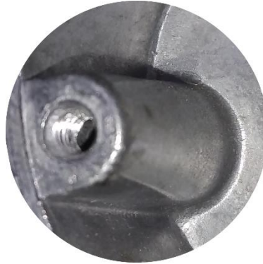
Rajah 7 : Gambar sampel threads pada Galvanised Steel Conduit Accessories yang menggunakan struktur binaannya sendiri sebagai preformed threads
