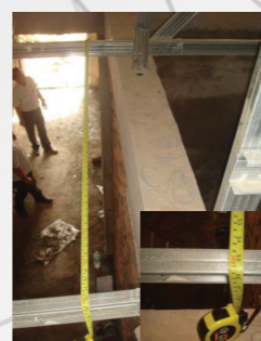
Jarak rentang antara kekuda diukur 1400mm c/c (melebihi 1200mm jarak maksimum spesifikasi)
