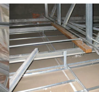
Web ditebuk dengan 'Bolt' untuk pemasangan penggantungan siling
