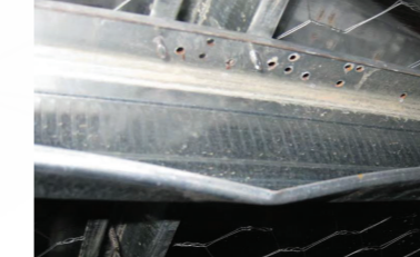
Lubang pada compression chord
