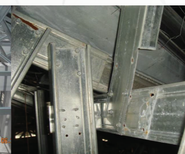
Kecacatan keratan sambungan (pemotongan keratan secara lebihan)
