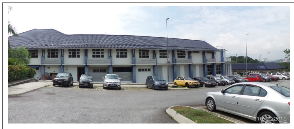
Gambar 5 : Gambar menunjukkan fasad sebelah barat (pandangan belakang) Blok Pentadbiran Balai Polis Presint 11 yang menunjukkan rekabentuk tropikal dengan bumbung 'pitched' dan cucur atap bumbung yang panjang.
