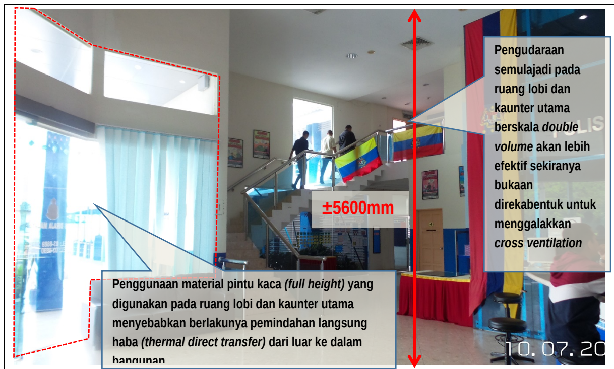
Gambar 8: Rekabentuk ruang lobi dan kaunter utama yang berskala 'double volume' dan penggunaan material kaca bagi pintu masuk utama yang tidak mengambilkira strategi rekabentuk pasif. Sukar untuk mencapai keselesaan termal yang optimum bagi ruang berskala 'double volume' dengan penggunaan kaca pada fasad bangunan tanpa bergantung kepada sistem pengudaraan mekanikal.
