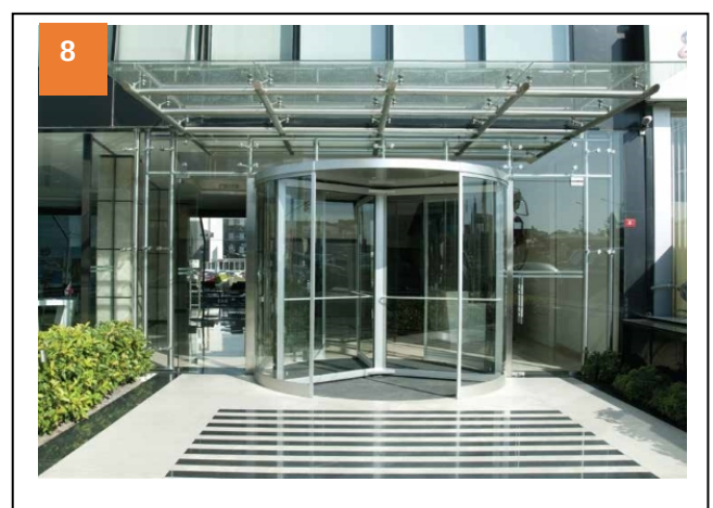
Gambar 7-8: Sistem pintu 'airlock' yang dapat memastikan haba dan suhu luar-dalam bangunan dapat distabilkan
