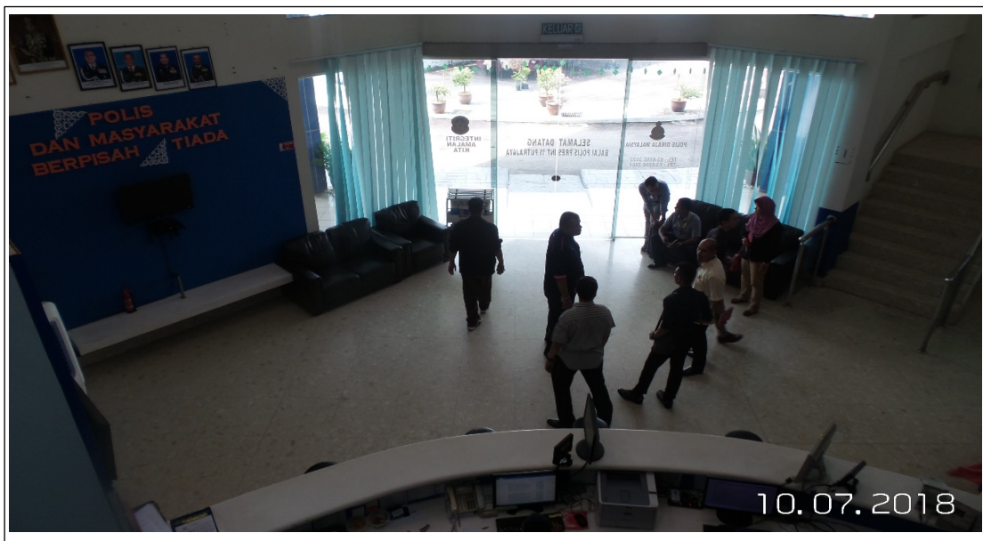
Gambar 21: Keadaan pencahayaan di ruang lobi dan kaunter utama berskala 'double volume' yang kurang mendapat pencahayaan siang. Bukan tingkap dan dinding kaca dilekatkan dengan lapisan 'tint' bagi mengelakkan silau cahaya dan pengumpulan haba daripada masuk ke dalam bangunan namun pada masa yang sama menghadkan penerimaan pencahayaan semulajadi.
