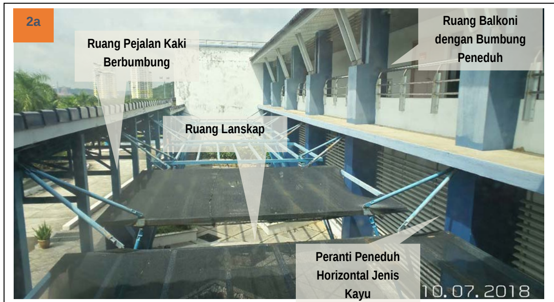
Gambar 2a: Ruang pejalan kaki berbumbung dan ruang landskap dengan struktur peneduh direkabentuk sebagai elemen transisi dan pemisah kepada fasad utama. Fasad utama blok pentadbiran dua tingkat ini direkabentuk dengan ruang balkoni yang lebar serta bumbung peneduh yang besar bagi memastikan teduhan cahaya yang efektif. Manakala pada aras bawah, peranti peneduh horizontal jenis kayu digunakan bagi tujuan teduhan dan pengudaraan semulajadi namun masih membolehkan pencahayaan memasuki ruang tersebut.
