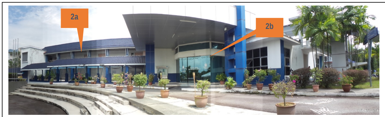
Gambar 2: Gambar menunjukkan Blok Pentadbiran Kompleks Balai Polis Presint 11 yang direkabentuk menghadap arah Timur. Orientasi fasad paling panjang ('longitudinal orientation') direkabentuk menghadap matahari pagi.
