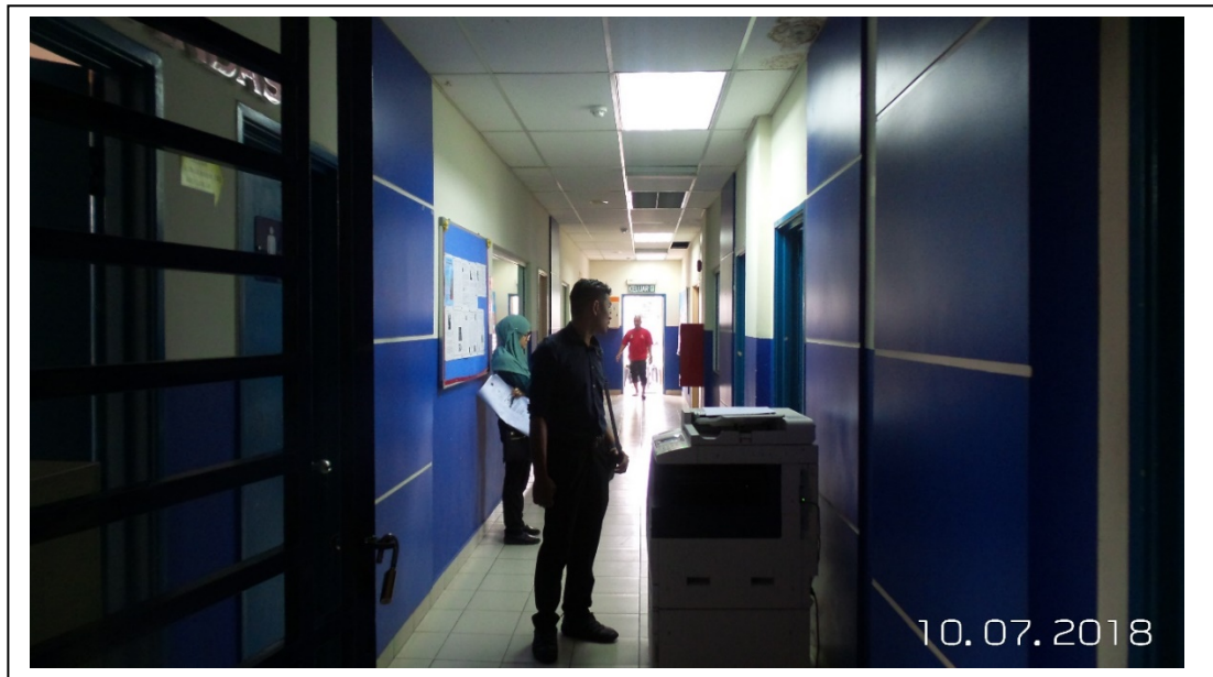
Gambar 17: Keadaan koridor di aras bawah. Rekabentuk 'double loaded corridor' telah menyebabkan bukaan pada ruang ini terhad dan pencahayaan siang terhalang. Kawasan ini bergantung sepenuhnya kepada cahaya buatan untuk pelaksanaan aktiviti dan operasi harian.
