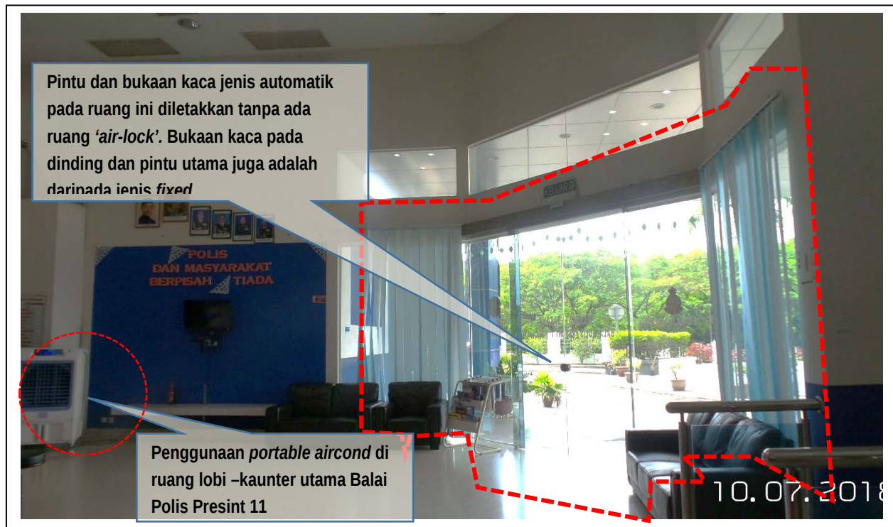
Gambar 7 : Penggunaan bukaan pintu automatik dan dinding kaca pada ruang lobi dan kaunter utama (Zon Awam –Separa Awam) Balai Polis Presint 11 yang direkabentuk tanpa ruang air-lock menyebabkan keselesaan termal sukar di capai. Pemerhatian mendapati strategi rekabentuk pasif bagi aspek pengudaraan semulajadi pada ruang ini kurang diberi penekanan oleh perekabentuk.
