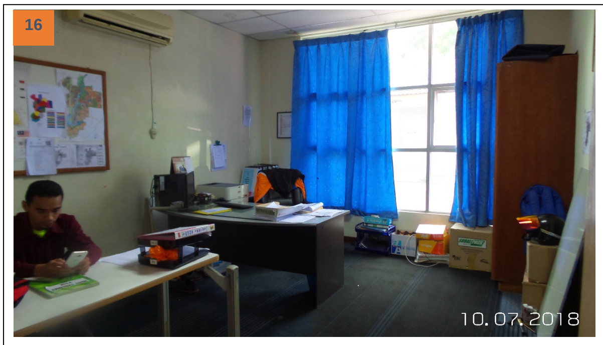
Gambar 15 & 16: Keadaan bilik-bilik pegawai di aras bawah. Bagi menghalang silau cahaya, pengguna terpaksa menutup langsir dan cahaya siang tidak dapat dimanfaatkan sepenuhnya.
