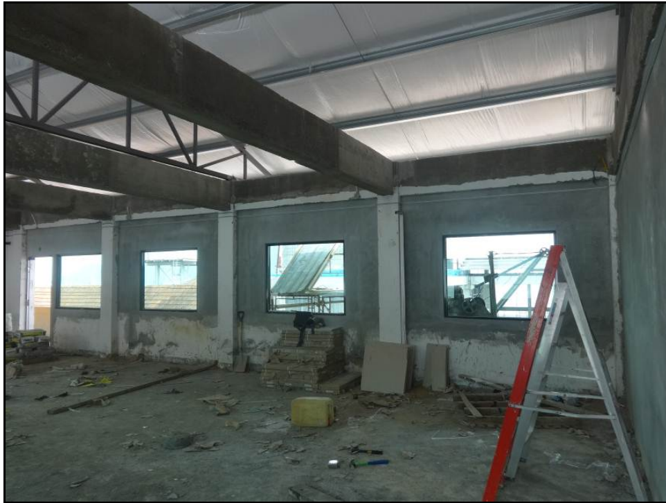
Gambar 2.27 : Kerja Naiktaraf Bangunan 3 Tingkat
