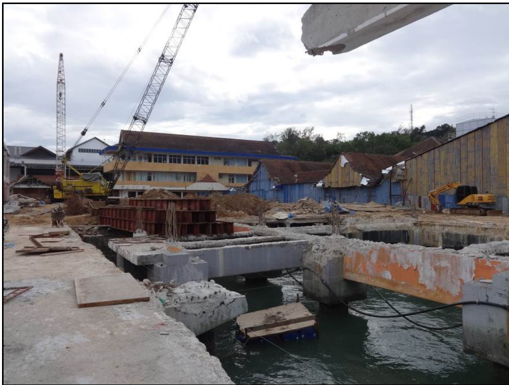
Gambar 2.22 : Struktur Sediaada Digunakan Semula Untuk Kerja-Kerja Naiktaraf
