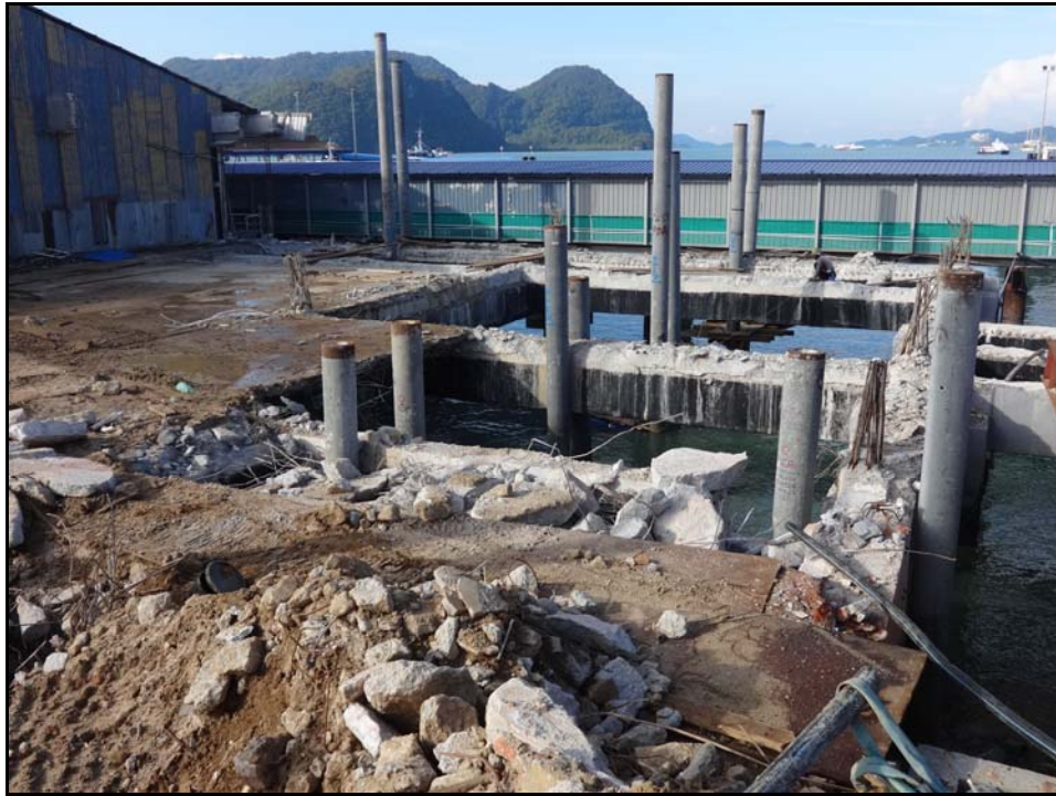
Gambar 2.17 : Kerja Meroboh Struktur Sedia Ada
