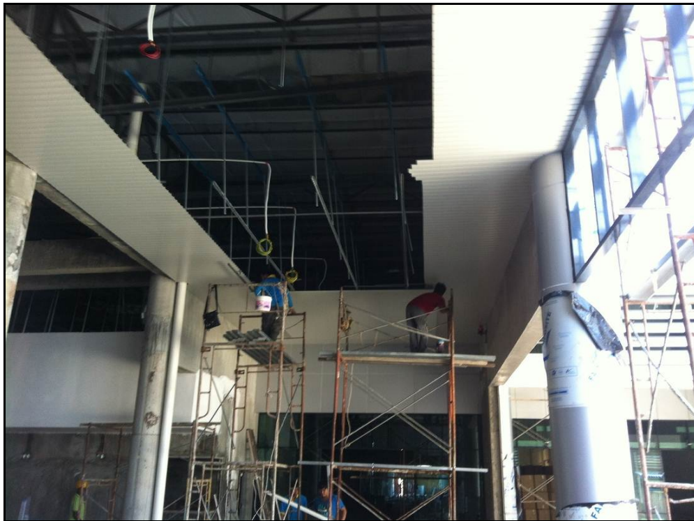
Gambar 2.30 : Kerja Pemasangan Pendawaian Elektrik
