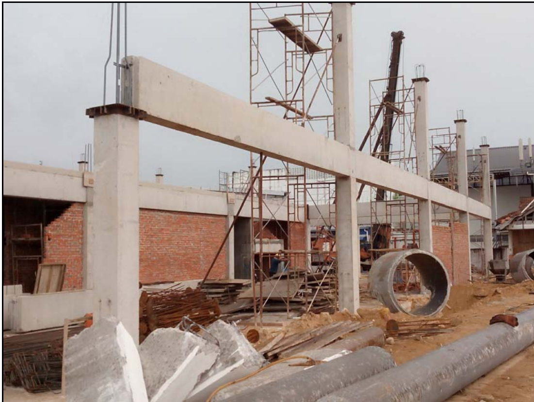
Gambar 2.26 : Penggunaan IBS Bagi Bangunan CIQ
