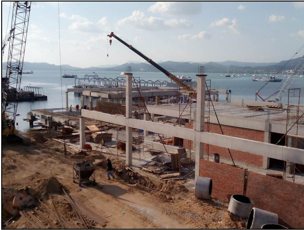
Gambar 2.25 : Pembinaan Bangunan CIQ
