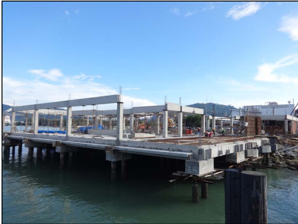
Gambar 2.18 : Bangunan CIQ Di Atas Paras Air
