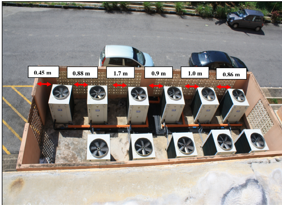
Gambar 7: Jarak yang terlalu rapat diantara tembok dan antara unit outdoor yang lain.
