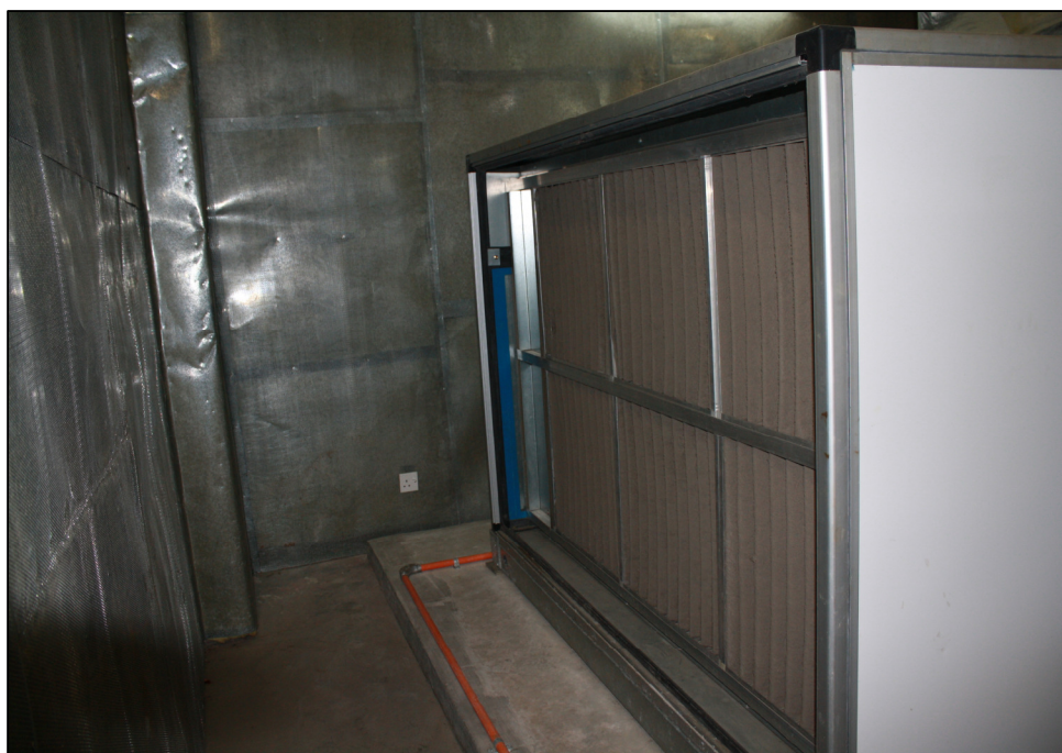
Gambar 10: Menunjukkan keadaan air filter yang kotor
