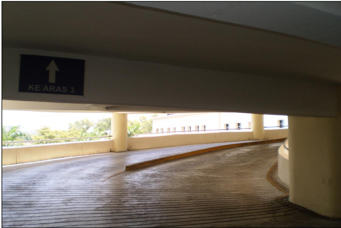
Foto 9.12 : Jalan keluar/masuk di Bangunan Tempat Letak Kereta
