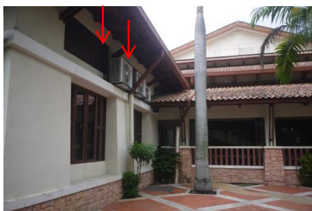
Gambar menunjukkan peranti teduhan tingkap jenis melintang dan juga jenis tingkap kaca yang terdapat di kebanyakan fasad bangunan Puspanitapuri.
