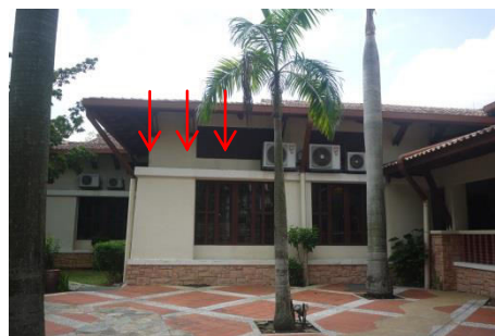
Gambar menunjukkan peranti teduhan tingkap jenis melintang dan juga jenis tingkap kaca yang terdapat di kebanyakan fasad bangunan Puspanitapuri.
