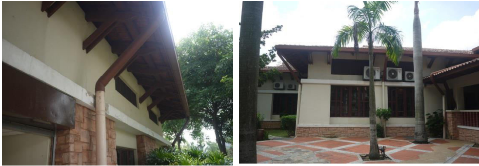
Gambar menunjukkan bukaan tingkap di bahagian atas siling yang terdapat di fasad bangunan
