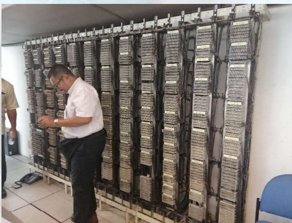
Subscriber Distribution Frame (SDF) yang masih menggunakan kabel jenis Multipair (Copper Cable) untuk sistem telefon
