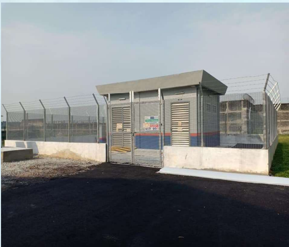
Pemasangan Pencawang TNB
