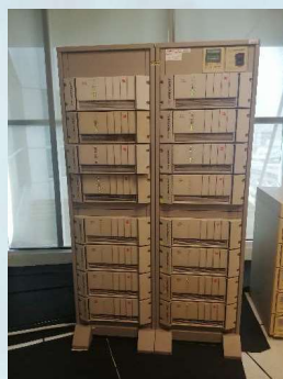
Floor Stand Uninterruptible Power Supply (UPS) dan Rectifier yang terdapat di Bangunan Sultan Iskandar, Johor yang berusia hampir 15 tahun yang mana backup time hanya selama 10 minit
