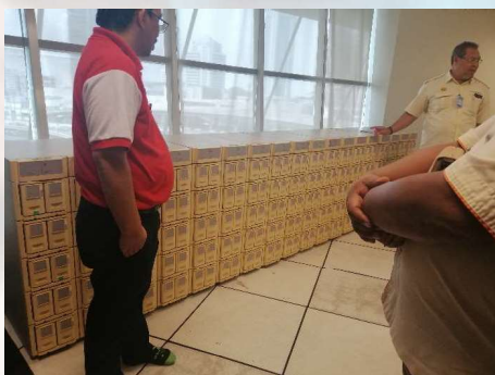
Floor Stand Uninterruptible Power Supply (UPS) dan Rectifier yang terdapat di Bangunan Sultan Iskandar, Johor yang berusia hampir 15 tahun yang mana backup time hanya selama 10 minit
