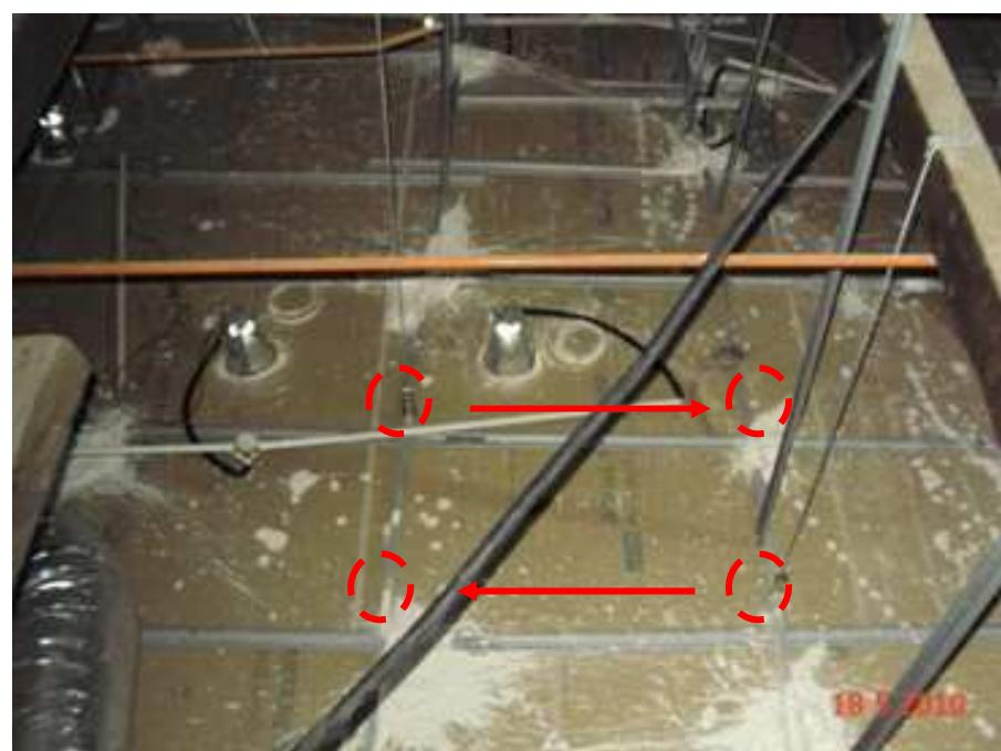
10. Tiada gantungan berasingan untuk sistem lampu.
