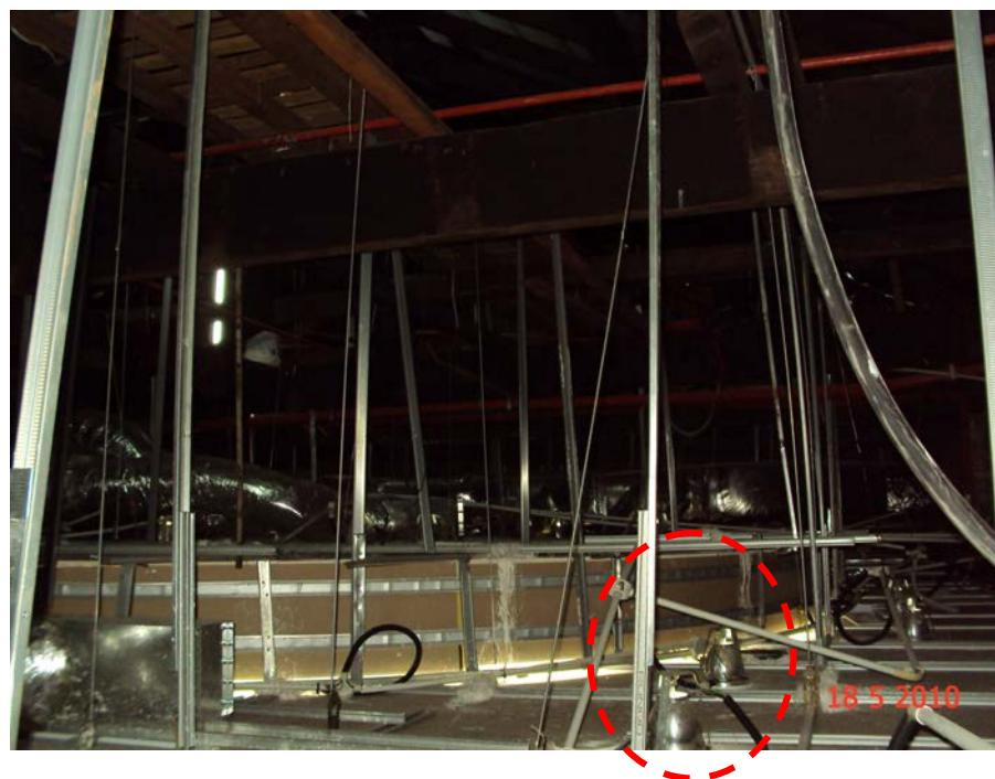
11. Struktur *GI channel* yang telah rosak masih digunakan sebagai gantungan.
