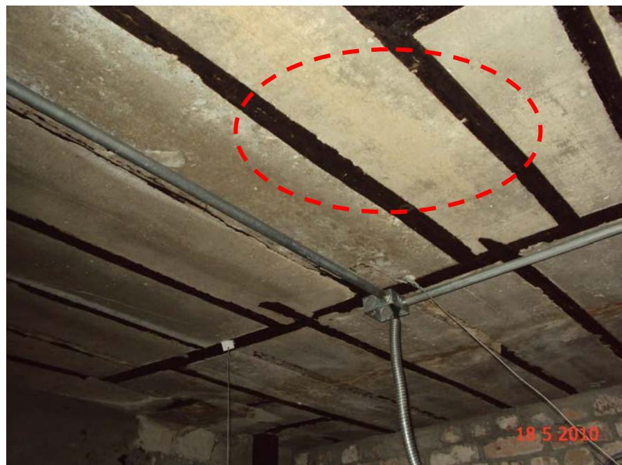
6. Gambar semasa kejadian menunjukkan *wall-plug* plastic pada *soffit* papak bumbung sebagai penyokong gantungan bagi siling plaster telah tertanggal.
