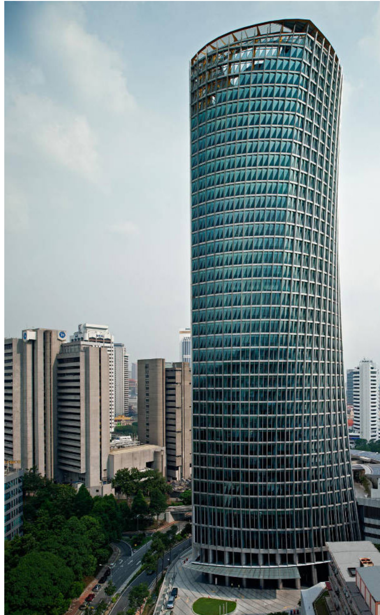
ON PHOTO : MENARA KERJA RAYA
