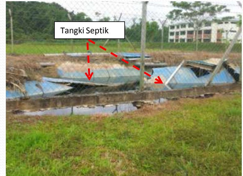
Foto: Kerosakan pada apron , tangki septic, longkang dan paip air di Sekolah Menengah Kebangsaan Sebauh, Bintulu, Sarawak.
