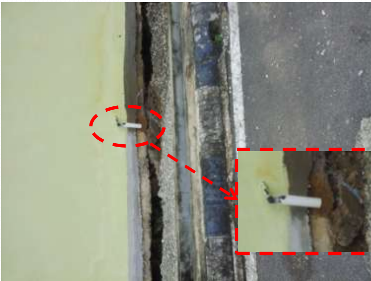
Foto: Kerosakan pada apron , tangki septic, longkang dan paip air di Sekolah Menengah Kebangsaan Sebauh, Bintulu, Sarawak.
