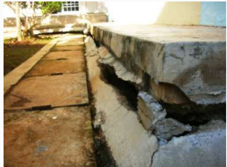
Foto: Kerosakan pada apron , pump house , dan paip air di IKBN Kuala Perlis
