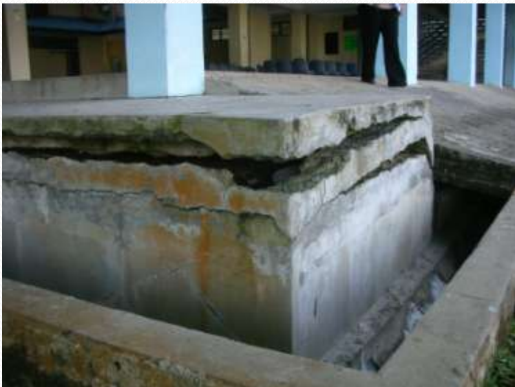
Foto: Kerosakan pada apron , pump house , dan paip air di IKBN Kuala Perlis
