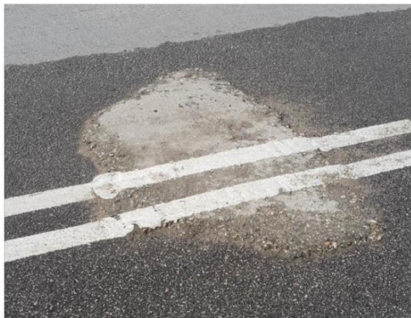
GAMBAR 1 : Tumpahan konkrit di atas permukaan pavemen
