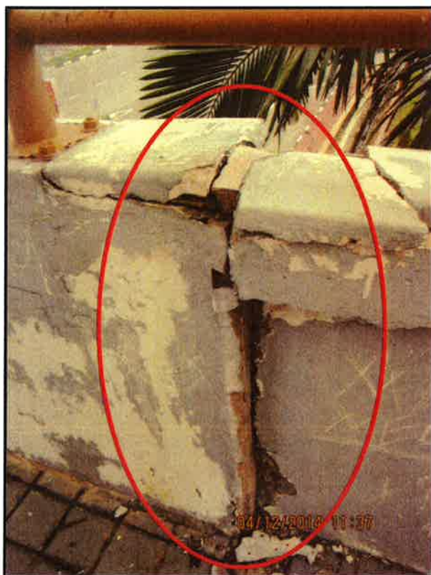
Gambar 13: Detachment pada struktur main crossing dan tangga
