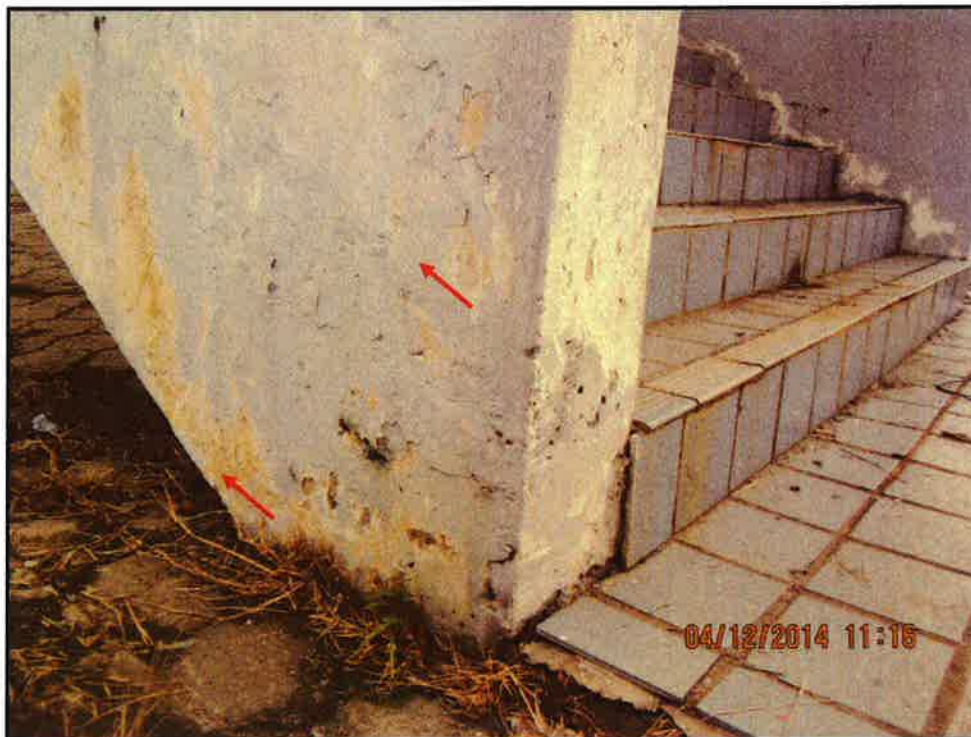
Gambar 2: Kesan Mendapan Struktur Tangga
