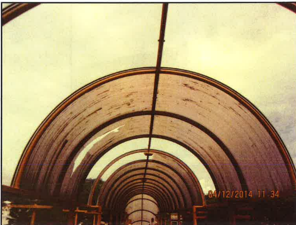
Gambar 23: Terdapat bumbung jejantas telah tercabut dan mengalami kerosakan
