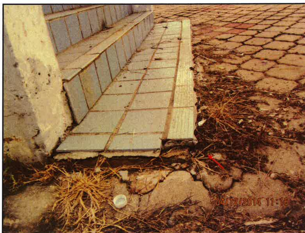
Gambar 3: Kesan Mendapan Struktur Tangga
