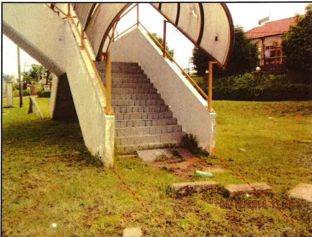
Gambar 7: Tiada laluan yang sesuai dibina untuk disambung ke tangga jejantas bagi pejalan kaki
