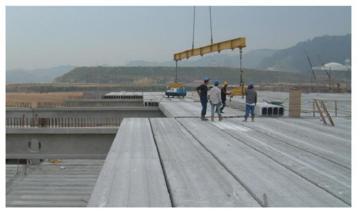
Kerja pemasangan Hollow Core Slab ditapak bina.
