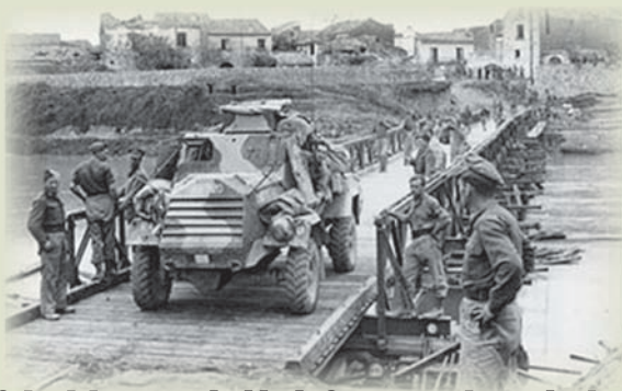
Sebuah kereta perisai jenis Otter menyeberangi sebuah Jambatan Bailey di Sungai Volturno berhampiran Grazzanise, 14-16 Oktober 1943. Jambatan Bailey mudah dipasang dan amat fleksibel
