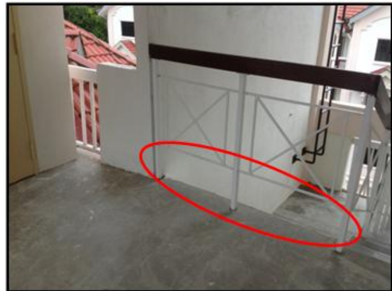
Gambar 31: Gap Bawah Susur Tangga Yang Terlalu Luas
