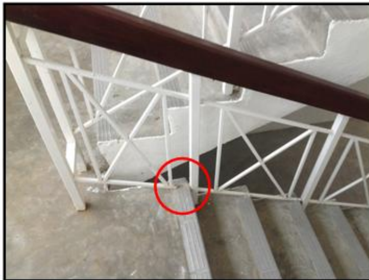
Gambar 30: Binaan Susur Tangan Menembusi Tangga
