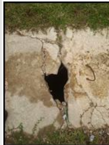
Gambar 9: Penutup Longkang Yang Tidak Sempurna
