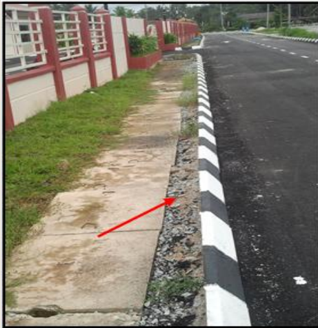
Gambar 4: Ruang Antara Bebendul Jalan dan Longkang Tidak Ditanam Rumput
