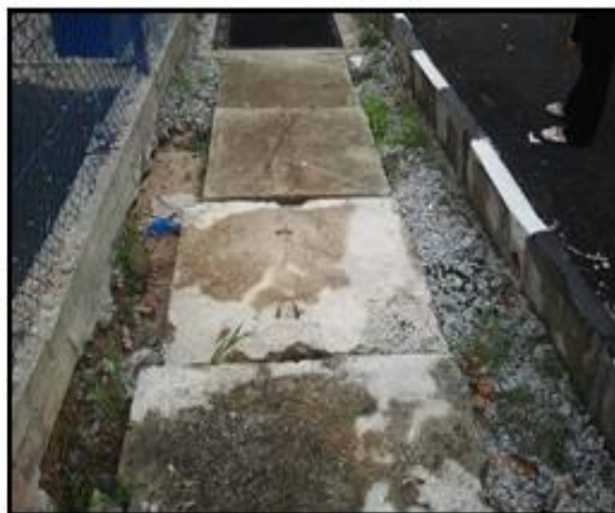
Gambar 9: Penutup Longkang Yang Tidak Sempurna
