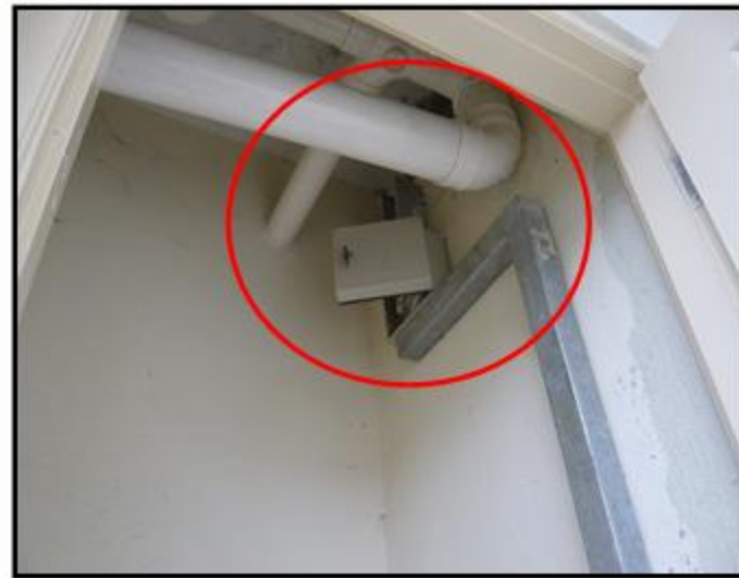
Gambar 25: Paip Sanitari Di Pasang Di Dalam Bilik Telefon Blok Kuarters G
