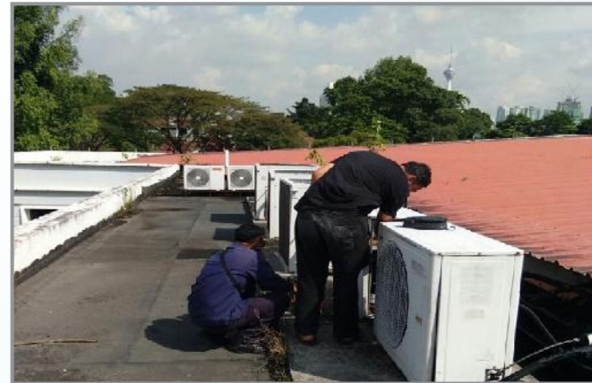
Kerja-kerja penyenggaraan alat penyaman udara
