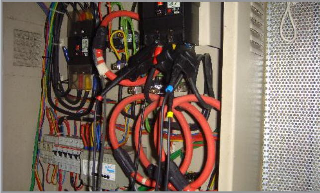
Pemasangan transducer ke papan agihan sistem-sistem mekanikal yang terlibat
