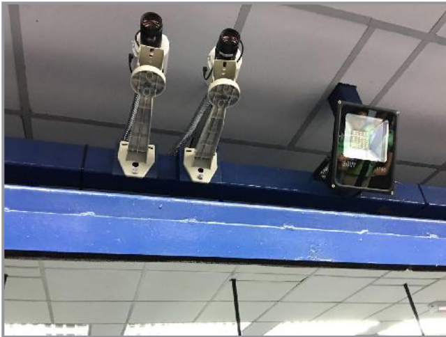
Sistem video yang dipasang pada kedudukan 15m, 20m dan 25m
