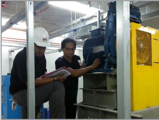
Pemasangan Motor Lif
