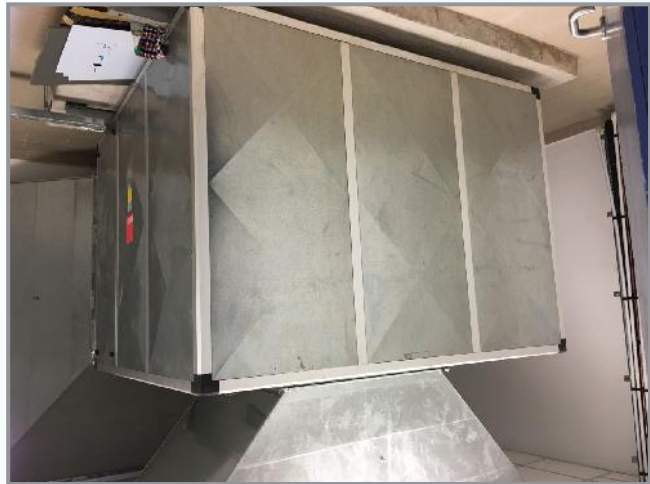
Sistem Penyaman Udara (Spot Cooling)
