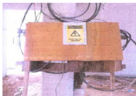
Box Penyambungan Elektrik
