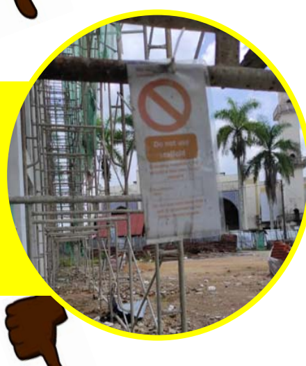
Pemasangan Red Tag Yang Jelas
