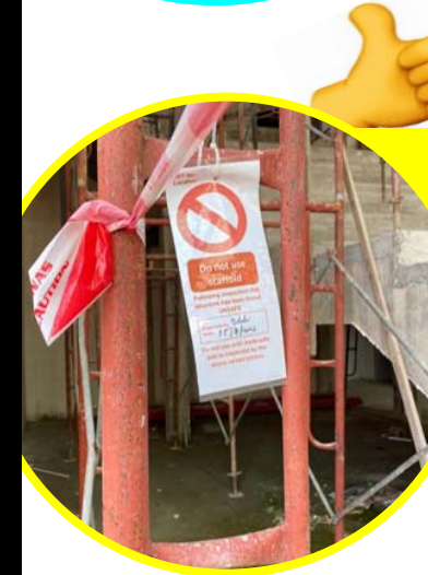
Pemasangan Red Tag Yang Jelas
