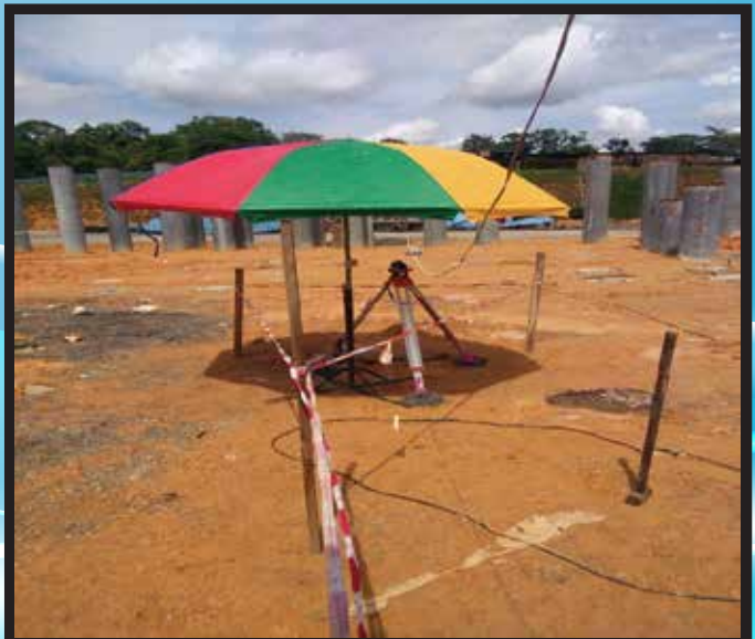
5 'Dumpy Level' digunakan untuk melihat integriti cerucuk
