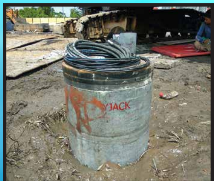
6 Cerucuk yang telah siap ditanam dan sedia untuk melakukan ujian
