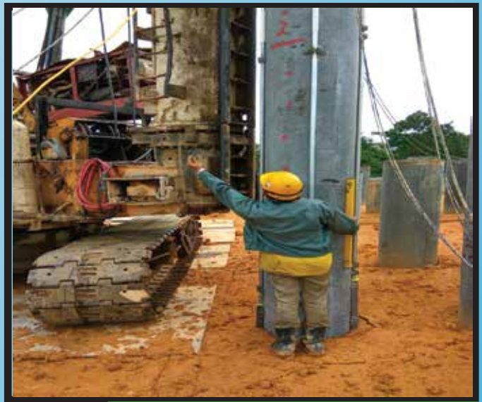
4 'Spirit Level' digunakan semasa kerja-kerja penanaman cerucuk
