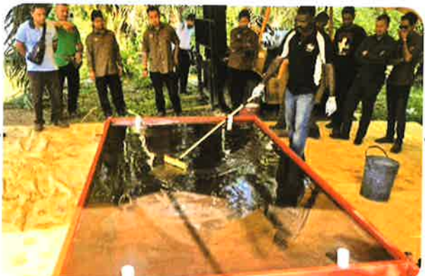
3. Setelah campuran Epoxy sebat, ianya dituangkan keatas permukaan decking sehingga sekata dan di biarkan selama 3 minit supaya epoxy menjadi sekata sebelum aggregate di taburkan di atas permukaan decking.
