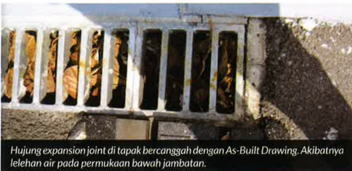
Pemasangan Bridge Brass Plaque di tapak tidak mengikut lukisan pembinaan dan bercanggah dengan As-built drawing. Akibatnya brass plaque ini akan mudah dicuri.
