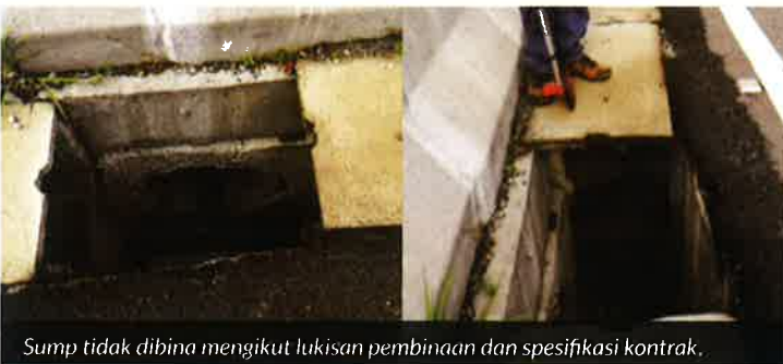
Sump tidak dibina mengikut lukisan pembinaan dan spesifikasi kontrak.
