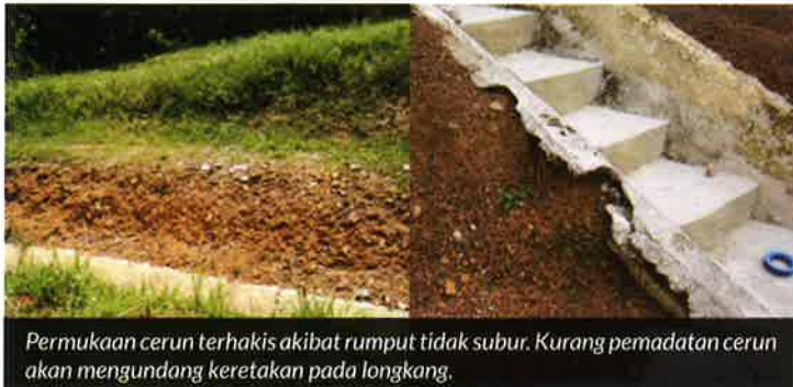
Outlet culvert dipenuhi air bertakung. 'Flushing' tidak dilaksanakan untuk pemeriksaan 'gradient' dan aliran longkang.
