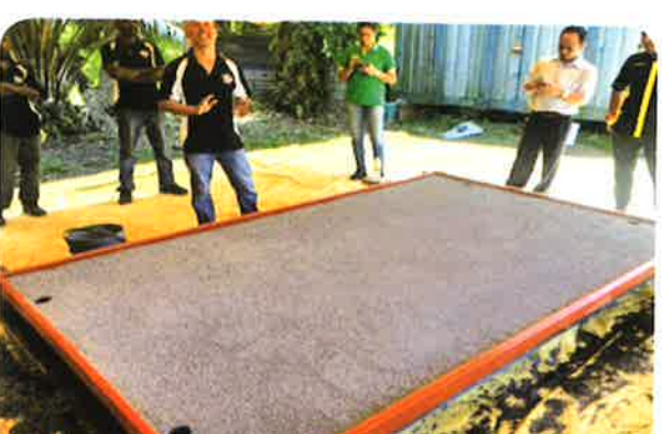
6. Setelah proses pengeringan selesai, permukaan decking akan di vacuum bagi membuang lebihan yang tidak melekat bagi mendapatkan hasil kerja yang sekata
