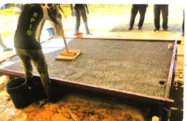
5. Setelah proses menabur memenuhi permukaan decking, kerja menekan permukaan decking dengan menggunakan kayu perata sehingga mampat. Setelah selesai, proses pengeringan coated selama 1 hari sehingga 2 hari mengikut keadaan cuaca. Tebal coated pada permukaan decking antara 4mm sehingga 5 mm.
