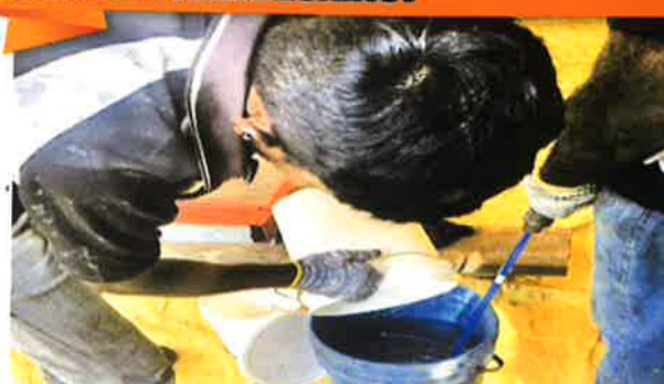
2. Proses mencampurkan bahan menggunakan bahan epoxy (5 kg) + 15kg aggregate. Jenis bahan epoxy dan aggregate hendaklah mengikut spesifikasi pembekal CPD 'CIPADECK TOD-99S Traffic Deck Overlays dan 'TRAPROCK#8.
