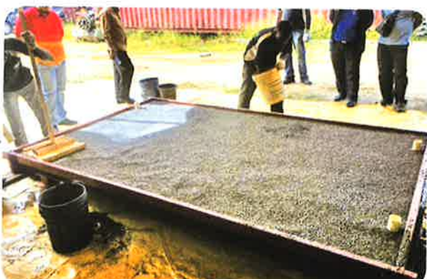
4. Setelah campuran Epoxy sekata, proses menabur aggregate yang bersaiz 3mm - 5mm sehingga sekata.
