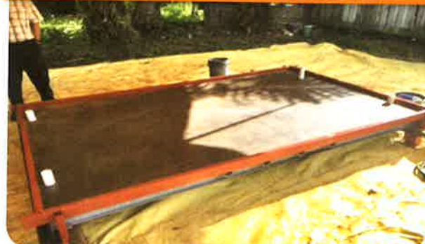
1. Decking yang telah siap dibersihkan setelah kerja-kerja mencungkil coated yang sedia ada. Decking perlu dibersihkan menggunakan sand bashing bagi membuang karat-karat yang ada di permukaan decking.
