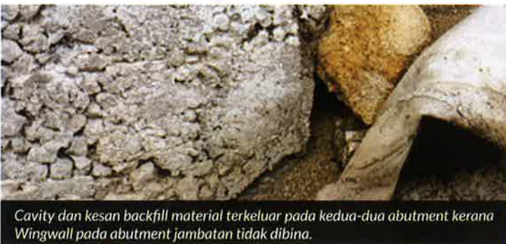
Hujung expansion joint di tapak bercanggah dengan As-Built Drawing. Akibatnya lelehan air pada permukaan bawah jambatan.
