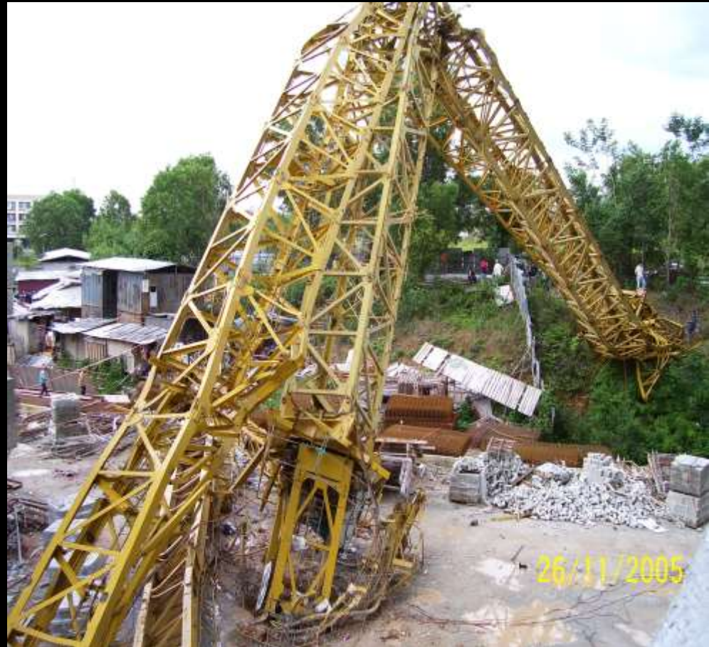
Kren menara tumbang menghempap rumah kongsi pekerja
