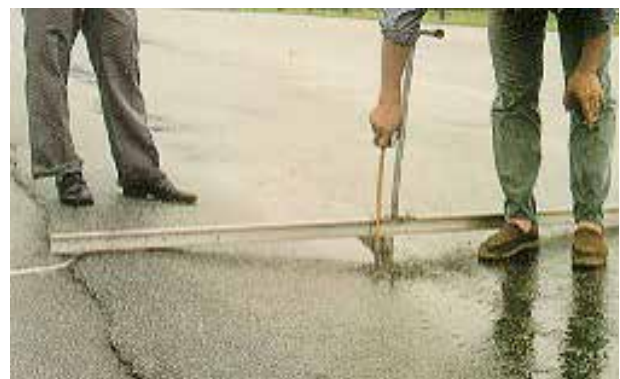
Rutting dan shoving terbentuk pada turapan jalan di lorong mendaki.
