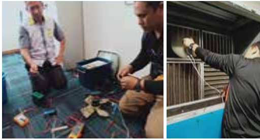
Pembangunan dan pengujian Idea 1 dengan rekabentuk satu kipas di bilik AHU Blok A, CREaTE.
