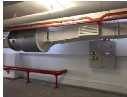
Exhaust Fan Untuk Sistem Pengudaraan Mekanikal Dilengkapi Dengan Service Platform
