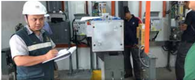
Pemeriksaan 1st Schedule Oleh Jabatan Keselamatan Dan Kesihatan Pekerjaan (JKKP)
