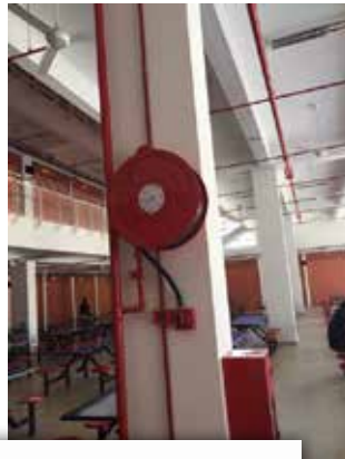
Hose Reel Drum Ditempatkan Di Kedudukan Yang Tinggi Untuk Mengelakkan Vandalisme
