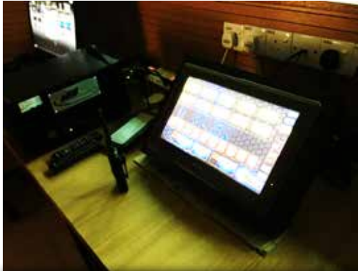
Bilik Kawalan Utama Yang Menempatkan Sistem Kawalan Integrasi Utama Merangkumi Lighting, Audio, CCTV, Ventilation, Card Access, Target System Dan Intercom
