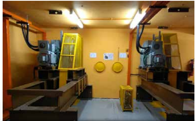
Traction Motor Yang Telah Siap Dibaik Pulih Semula Di Bilik Motor Lif
