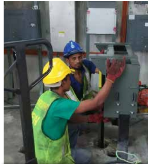
Kerja Pemasangan Motor Di Bilik Motor Lif Sedang Dijalankan
