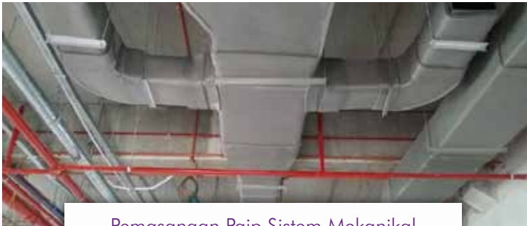
Pemasangan Paip Sistem Mekanikal
