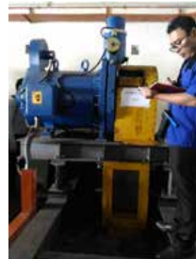
Pemeriksaan Motor Lif Di Bilik Motor Lif
