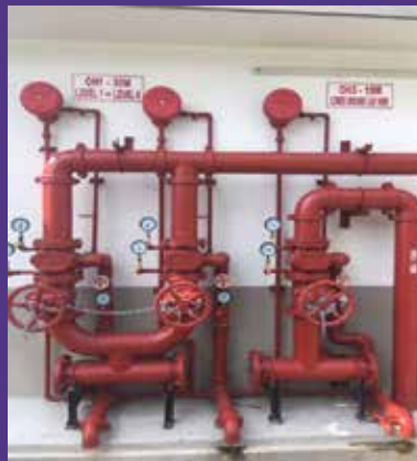
Sprinkler Alarm Valve Jenis OH-I* Untuk Level 1 - Level 6 Dan OH-III* Untuk Lower Ground Carpark
