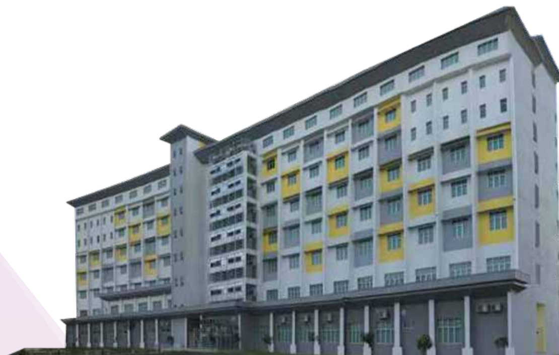
PEMBINAAN DI UNIVERSITI TUN HUSSEIN ONN MALAYSIA (UTHM) DI PARIT RAJA, BATU PAHAT, JOHOR : FAKULTI KEJURUTERAAN ELEKTRIK DAN ELEKTRONIK (FKEE) - BANGUNAN PENTADBIRAN DAN AKADEMIK
