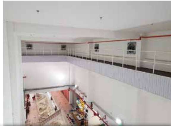
Exhaust Fan Untuk Sistem Pengudaraan Mekanikal Dilengkapi Dengan Service Platform
