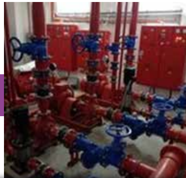
Peralatan Pam, Panel Dan Tangki Bagi Sistem Automatic Sprinkler & Wet Riser
