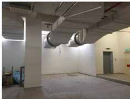
Sistem Pengudaraan Mekanikal/Sistem Smoke spill Di Basement 1 Dan Basement 2
