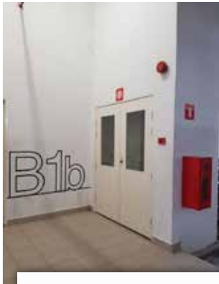
Hose Reel Drum Ditempatkan Di Kedudukan Yang Tinggi Untuk Mengelakkan Vandalisme
