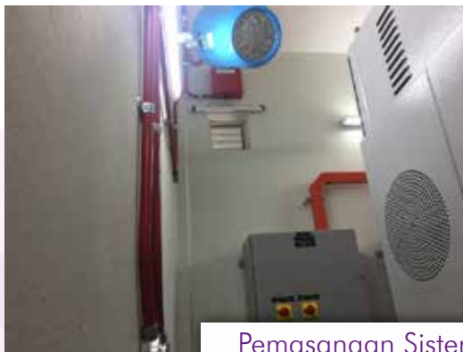
Sistem Pencegah Kebakaran Jenis Hose Reel Dan Fire Extinguisher
