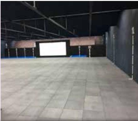
Lapang Sasar 25 Meter Dilengkapi Dengan Acoustic Wall, Floor Dan Ceiling Baffle (Rubber Tile) Untuk Tujuan Keselamatan
