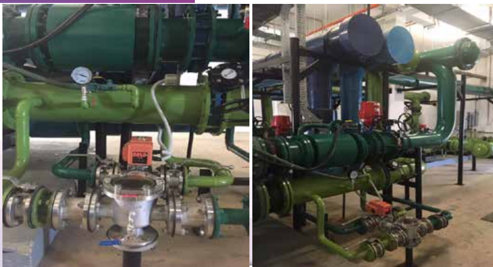
Sistem Chiller Dengan Fungsi Auto Condenser Cleaner
