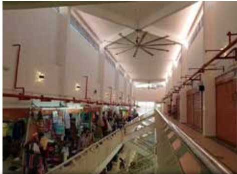
Perpaipan Untuk Sistem Automatic Sprinkler
