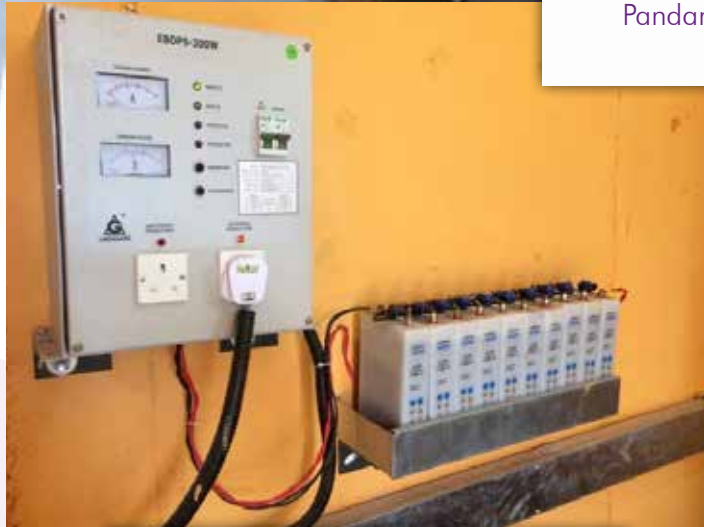
Sistem Lif Turut Dilengkapi Dengan EBOPS
