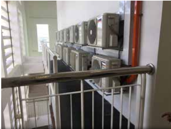
Outdoor Unit Untuk Sistem Penyaman Udara Diletakkan Pada Satu Ruang Khas Dilengkapi Platform
