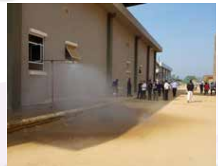
Pengujian Sistem Automatic Sprinkler
