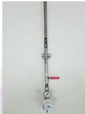
Sistem Gas Makmal Berpusat (Gas CO 2 & O 2 )
