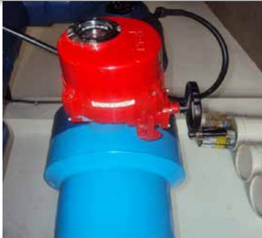
Motorised Valve Bagi Mengawal Kadar Alir Air Sejuk
