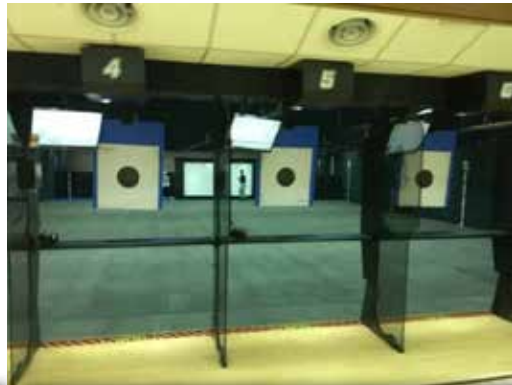
Shooting Booth Yang Dilengkapi Dengan Monitor, Panel Kawalan Individu, Headphone, Partition, Target Board, System Retrieval Target Dan Pengudaraan Untuk Penembak
