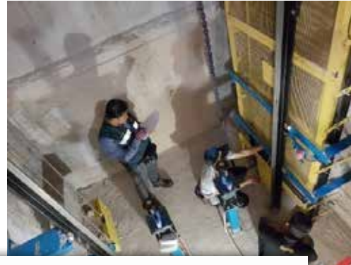
Pemeriksaan Pegawai Jabatan Keselamatan Dan Kesihatan Pekerja (JKKP) Bagi Pemasangan Sistem Lif
