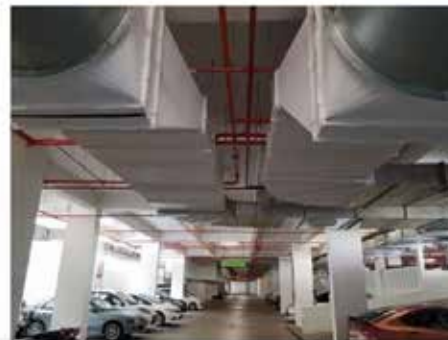
Sistem Pengudaraan Mekanikal/Sistem Smoke spill Di Basement 1 Dan Basement 2
