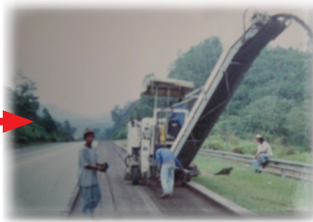
Teknik mill and pave.
