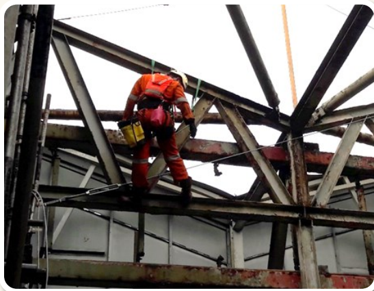
Gambar 4 : Kerja pemasangan sokongan sementara menggunakan wire rope .
