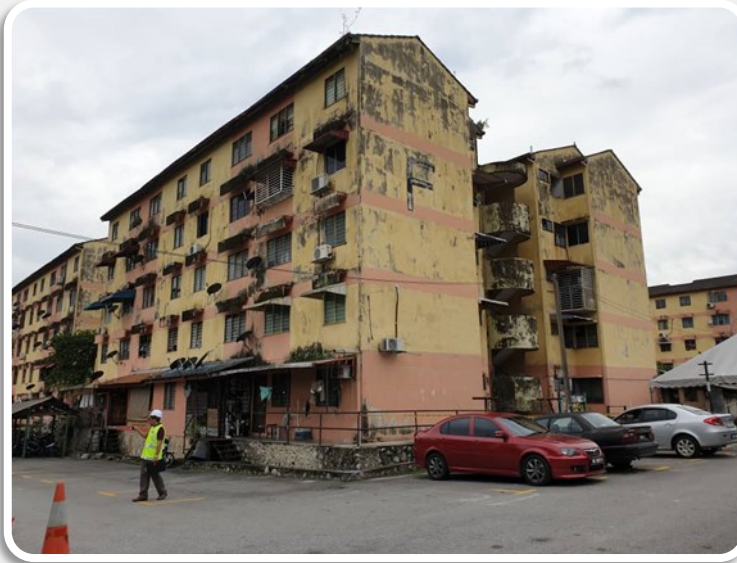
Gambar 1 : Pandangan pepenjuru bangunan Blok F.
