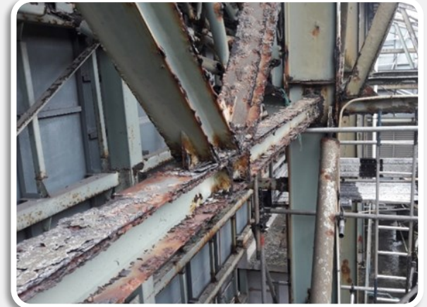
Gambar 2 : Kerosakan struktur dan kegagalan pada sambungan akibat pengaratan.
