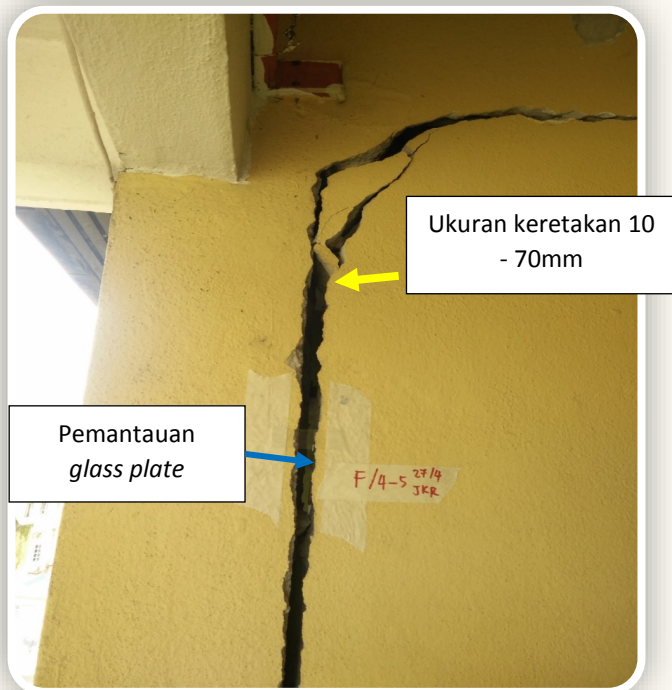
Gambar 4: Pengukuran regangan bagi mengumpul data dan pemasangan glass plate di sebahagian lokasi regangan dinding bata dengan tiang.
