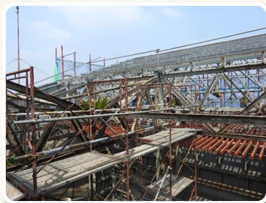
Gambar 6 : Kerja-kerja meroboh struktur rehal di Menara DBP.
