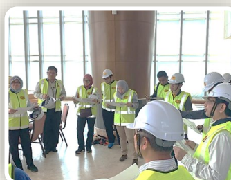
Gambar 7 : Lawatan pegawai teknikal bagi melihat kerja-kerja meroboh struktur rehal pada 3 Oktober 2019
