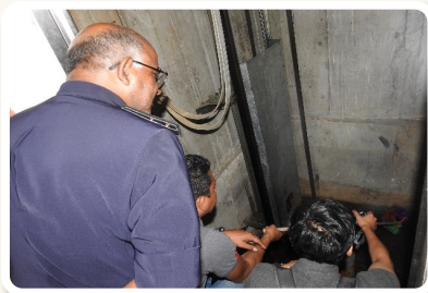
Pemeriksaan pada lubang lif di bangunan perumahan Balai Polis Pantai Remis, Perak.
