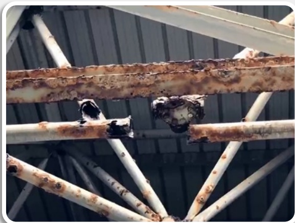
Gambar 2 : Kerosakan struktur dan kegagalan pada sambungan akibat pengaratan.
