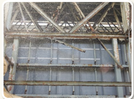
Gambar 5 : Runtuhan dan keadaan semasa selepas pemasangan sokongan sementara.
