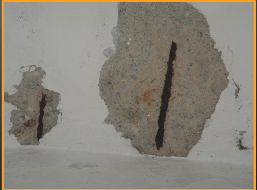
Spalling
