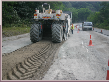
Kerja mengitar semula lapisan pavemen sedia ada.
