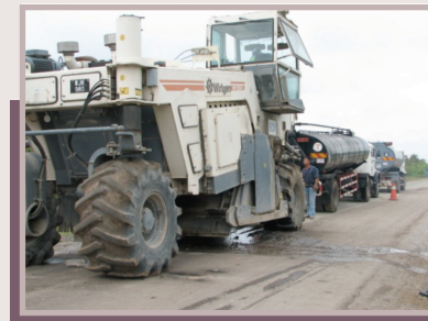
Mesin recycling yang digunakan bagi tujuan mengitar semula lapisan pavemen sedia ada di tapak.
