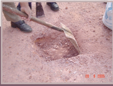
Penyediaan trial pit.
