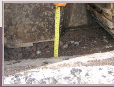
Pemeriksaan kedalaman lapisan yang dikitar semula sebelum dipadatkan.
