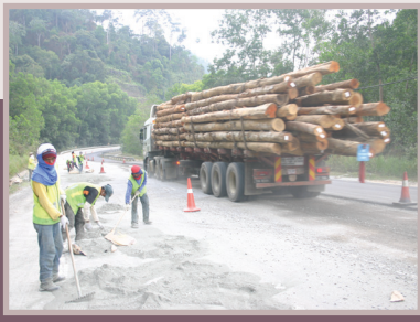
Penghamparan agen penstabil sebelum mesin recycling memulakan kerja.
