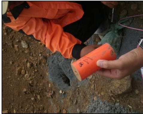
4. Memasukkan Booster (High Explosive) Ke Dalam Shot Hole
