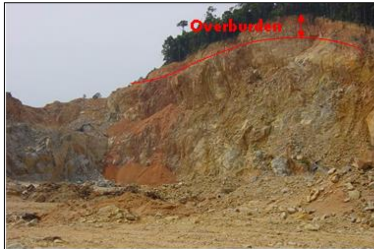
Rajah 4.1.1 : Membersih Tanah (Overburden)
