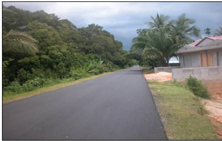
Rajah 4.7.4.3 : Selepas Laying
