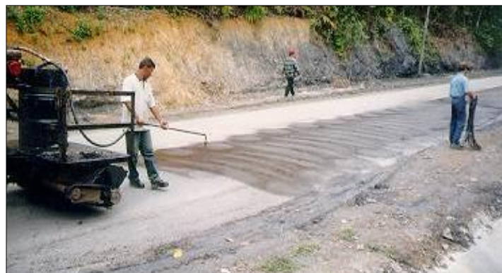
Rajah 4.7.2.2 : Kerja - kerja menyembur Tack Coat
