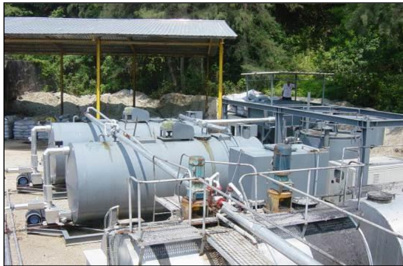
Rajah 2.3.2: Pemasangan tangki Bitumen untuk Penyelidikan bersama Lembaga Getah Malaysia
