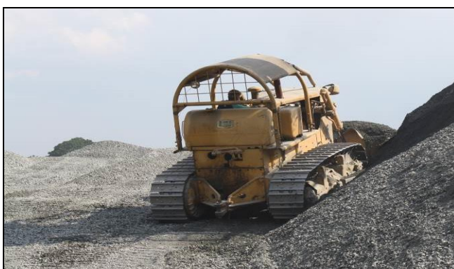
Rajah 3.3.3.1 : Jentolak (Bulldozer)
