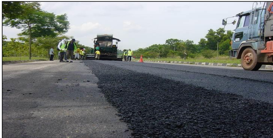
Rajah 2.2.1: Kerja-kerja Penurapan Jalan
