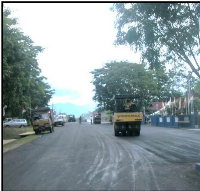
Rajah 4.7.4.2 : Kerja-kerja mengelek Premix menggunakan Rubber Tyre Roller
