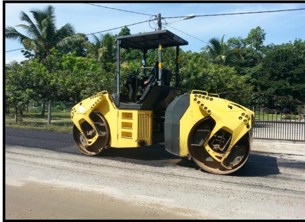
Rajah 4.7.4.1 : Kerja-kerja mengelek Premix menggunakan Vibrating Roller
