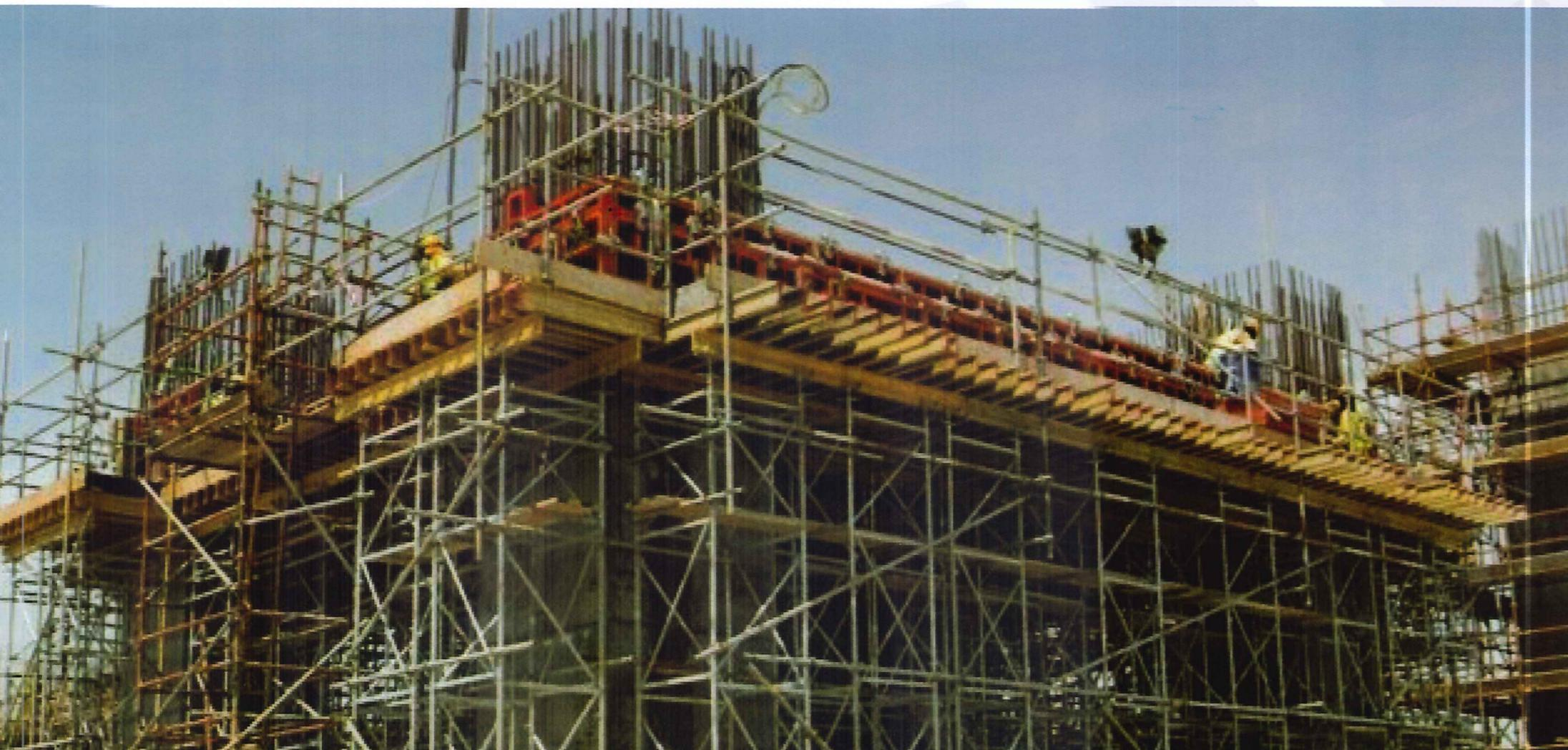
Kotak Acuan (formwork) termasuklah penyangga (shore), perembat (brace) dan tupang-tupang (supports) lain yang dilengkapi dengan bod jari (toeboard) dan rel pengadang (guardrails).
