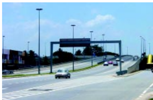
Jejambatan Jalan Keretapi-Laluan Persekutuan 74, Jalan Simpang-Taiping, Perak
