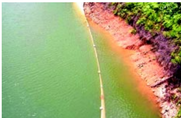
Pemasangan Tabir Kelodak (Silt Curtain) Bagi Mengelakkan Kelodak Masuk Ke Dalam Tasik Kenyir
