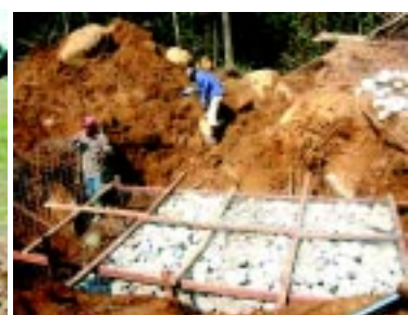
Pemasangan Perangkap Kelodak (Silt Trap)
