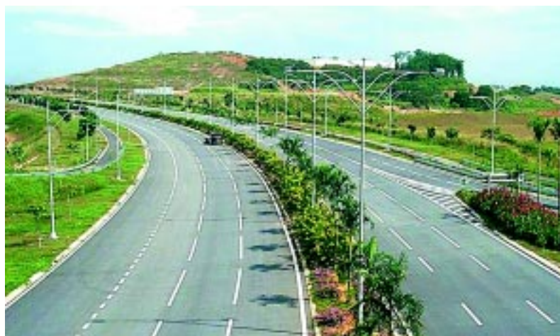
Jalan Penghubung Utama Di Putra Jaya (Jalan Lingkaran Bandar U4)
