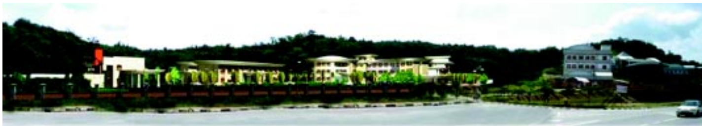
Pusat Pengurusan Maklumat Dan Multimedia Serta Pusat Kendalian Kecemasan Radiologi Kebangsaan, Lembaga Pelesenan Tenaga Atom (LPTA)
