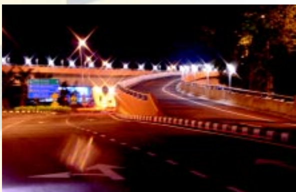
Persimpangan Bertingkat Jalan Sultan Azlan Shah-Jalan Gopeng/Jalan Kampar
