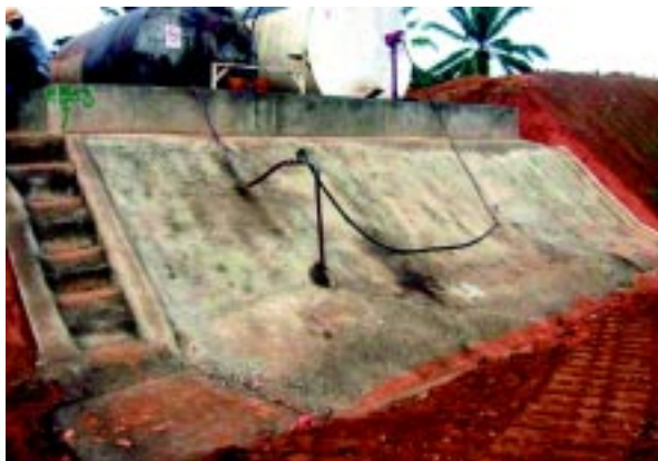
Pembinaan Ban Konkrit Bagi Mengelakkan Pencemaran Minyak Daripada Tangki Simpanan Diesel
