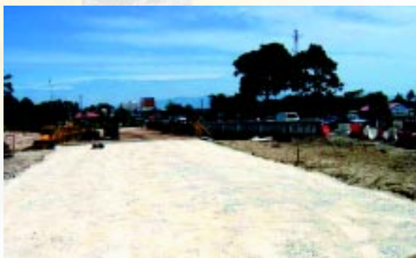
Pembinaan Jalan Lencongan
