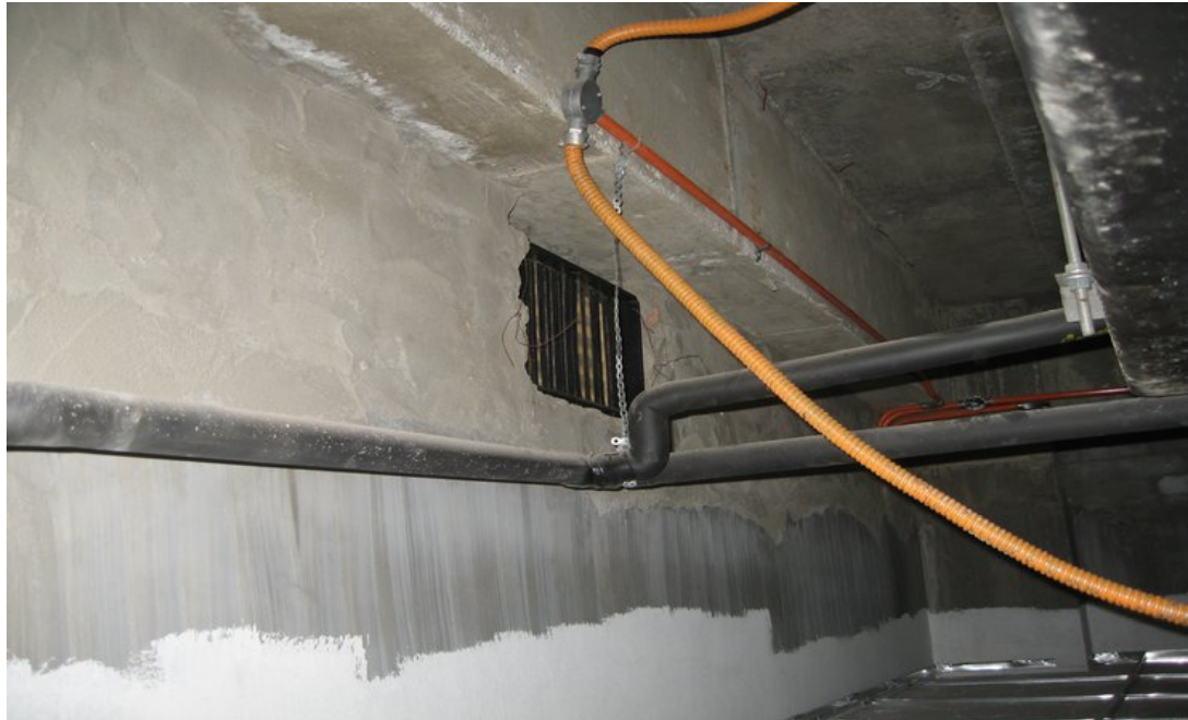
Gambar 9: Terdapat bukaan fresh air grill dalam ruangan siling di Bilik Perbincangan 10 Aras 6
