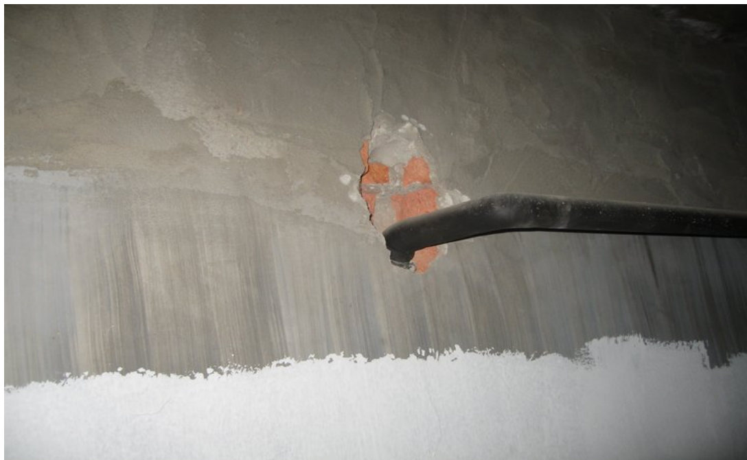
Gambar 10: Bukaan lubang pada paip penyejuk daripada out door unit dalam ruangan siling di Bilik Perbincangan 10 Aras 6.
