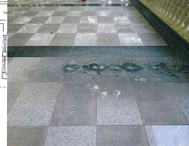
- Kesan bocor pada lantai
