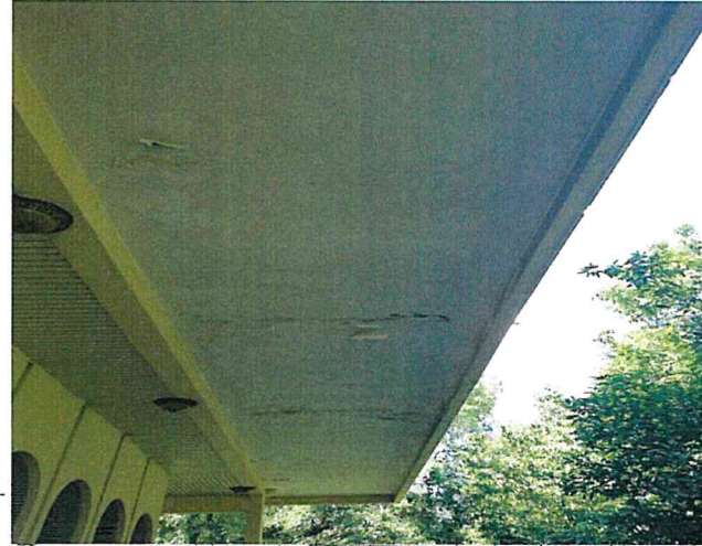
- Siling lembap, bocor dan cat mengelupas
