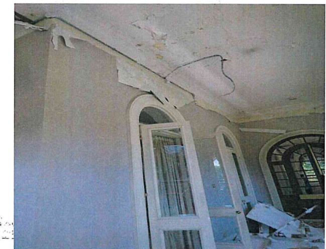
- Lapisan kertas dinding yang terkoyak
