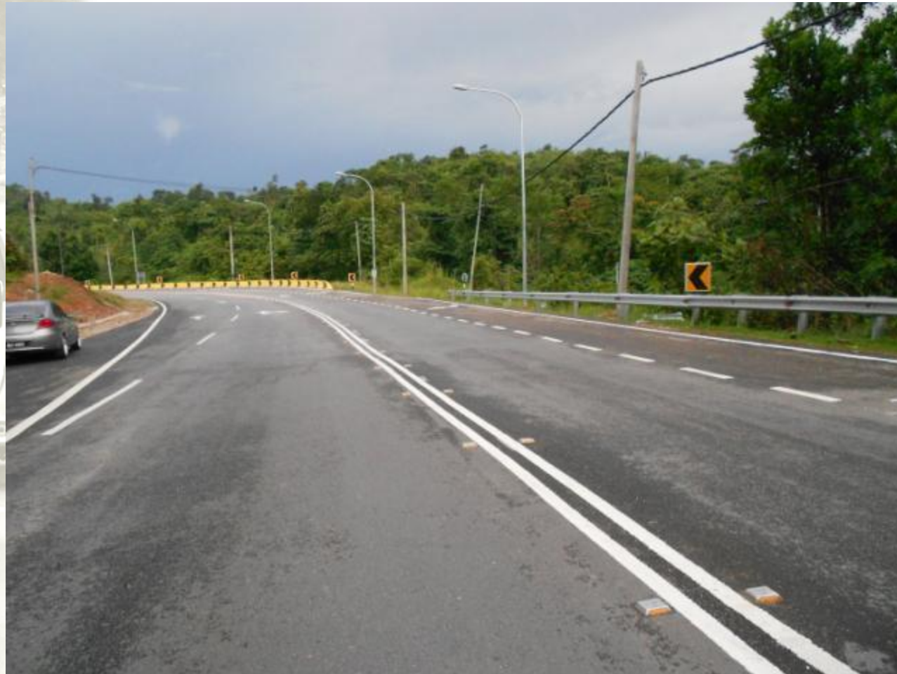
Foto : Kedudukan pepaku jalan dipasangkan 2 nos pepaku jalan jenis “bi directional yellow” di kiri dan kanan garisan berkembar
