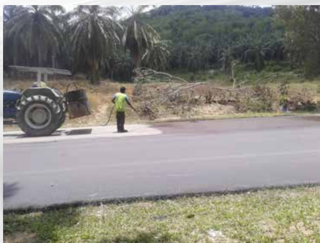
Kerja semburan tack coat di tapak
