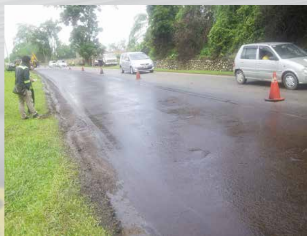
Permukaan jalan yang telah siap disemur dengan tack coat
