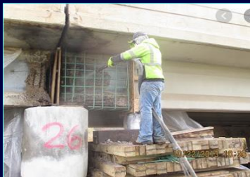
Pembaikan beam jambatan dengan kaedah formwork repair.
