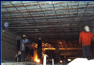
Pembaikan pada deck soffit pembetung konkrit dengan kaedah guniting.
