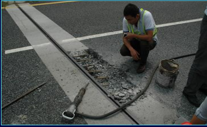
Pembaikan pada epoxy nosing expansion joint.
