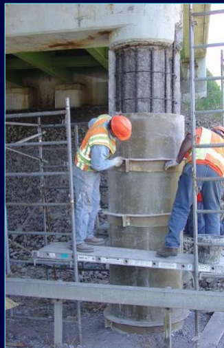
Pembaikan pier column jambatan dengan kaedah jacketting.
