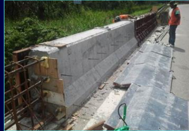
Pembaikan parapet konkrit dengan kaedah formwork repair.
