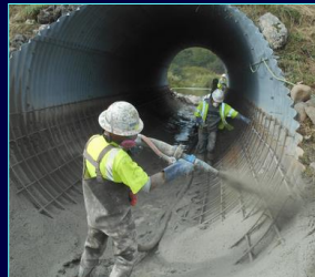
Pembaikan pembetung CMP dengan kaedah shotcrete pada base.
