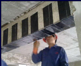
Pembaikan pier jambatan dengan aplikasi CFRP.
