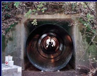
Pembaikan pembetung kotak konkrit dengan kaedah reline dengan CMP.
