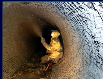
Pembaikan pembetung CMP dengan kaedah shotcrete pada base.
