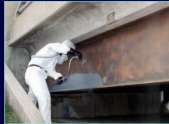
Aplikasi protective coating pada steel girder jambatan.
