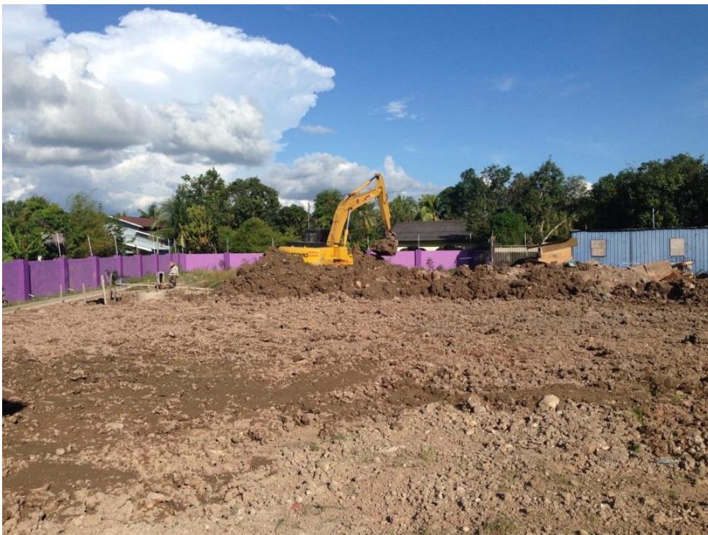
Kerja tanah bagi penyediaan datarn kejat
