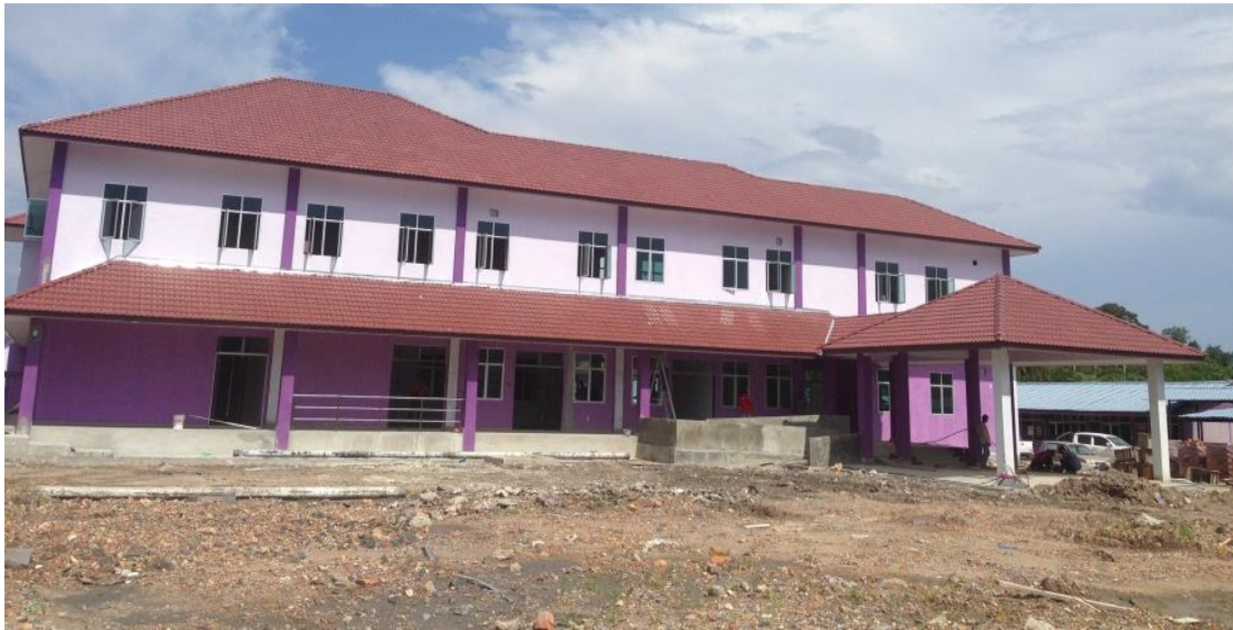
Pandangan Belakang Bangunan Pejabat Veterinar
