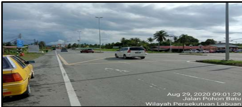
Persimpangan Jalan Pohon Batu / Jalan Tanjung Aru
