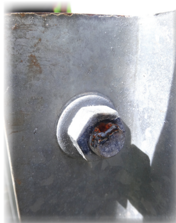
Spot welding ke atas bolt & nut.
