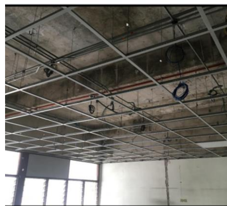
Kerja-kerja pemasangan ceiling frame
