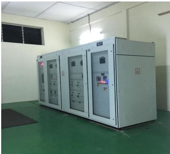
Pemasangan MSB Baru
