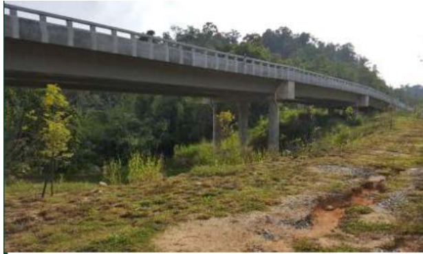
Viaduct Gerik, Jalan Gerik-Jeli
