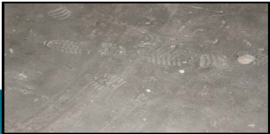
Kesan tapak kaki di lantai koridor, tiada penyeliaan yang rapi semasa pembinaan
