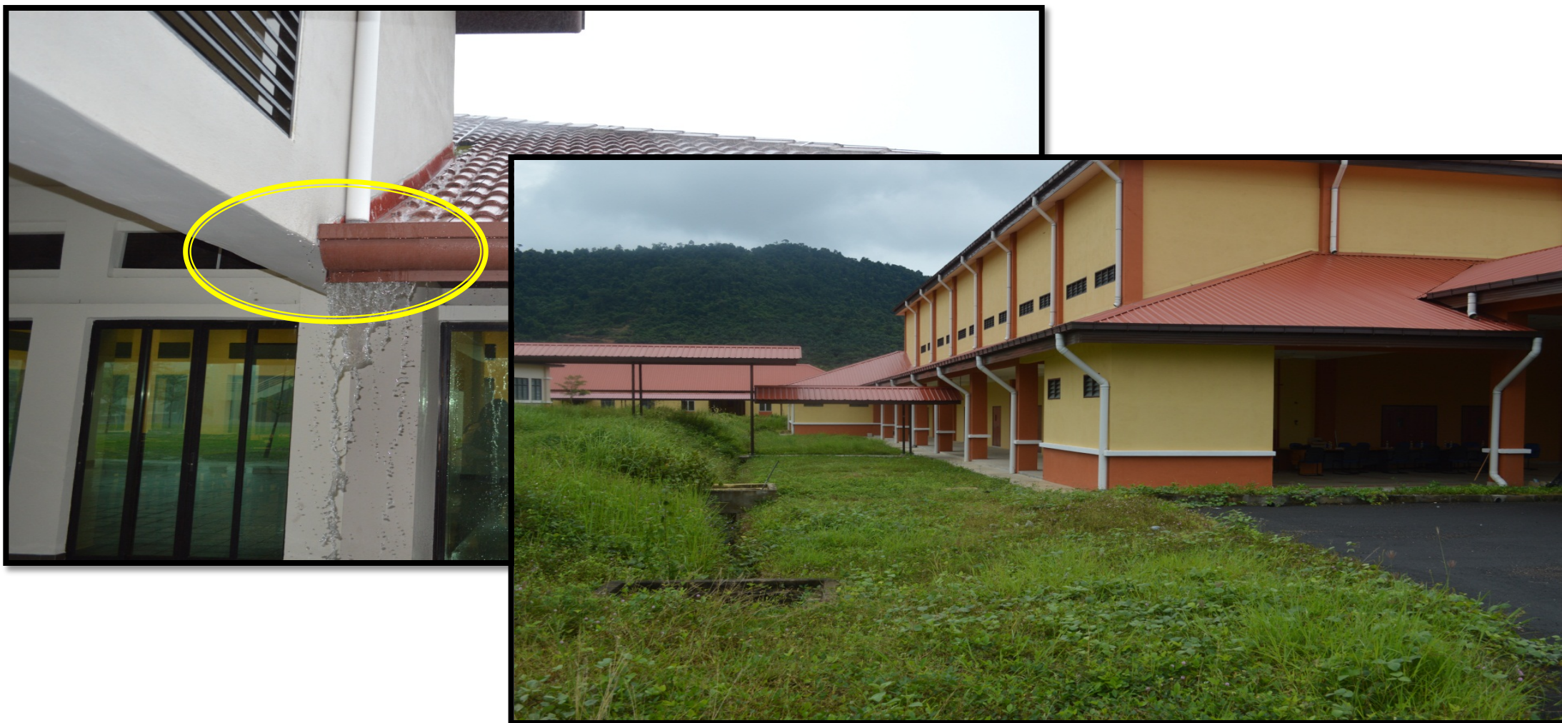
Air dari RWDP terus menerjah ke gutter
