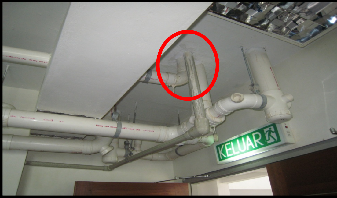
Paip buangan terlalu rendah dan terletak di dalam pejabat
