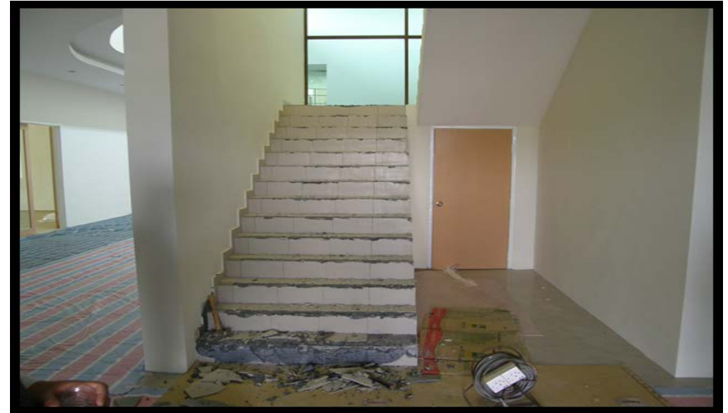
Kemasan tangga terpaksa dipecahkan dan dibina semula kerana ukuran anak tangga tidak mengikut lukisan
