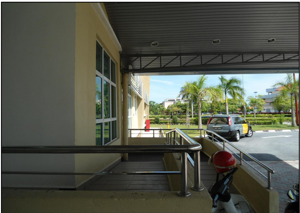
Gambar 9.14 : Ramp di laluan masuk ke bangunan PPS
