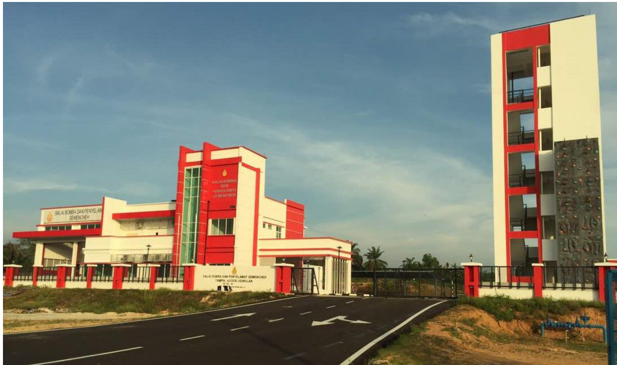
BALAI BOMBA DAN KUARTERS GEMENCHEH, TAMPIN, NEGERI SEMBILAN (NO. KONTRAK: JKR/IP/CKS/254/2015)
