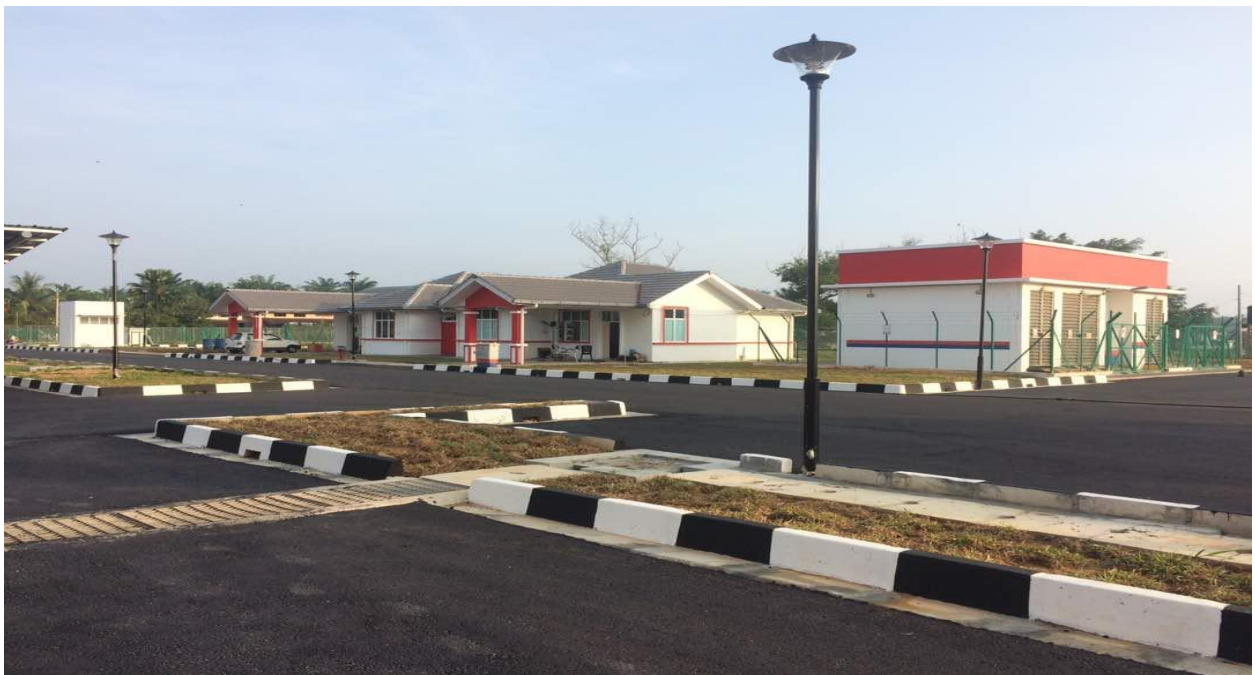
Kwarters Pegawai dan TNB Substation
