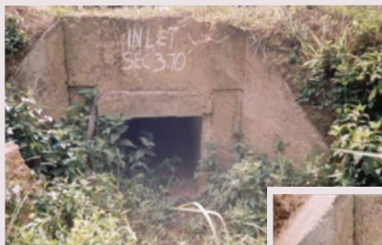
Laluan masuk/keluar pembetung yang bersih akan membenarkan aliran air masuk/keluar yang lancar.
