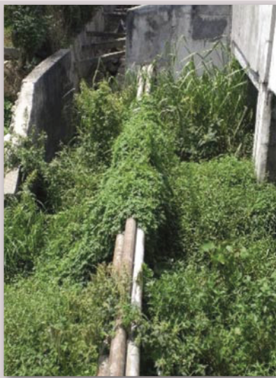
Bukaan pembetung yang dipenuhi tumbuhan mampu menghalang kelancaran aliran air masuk/keluar pembetung.
