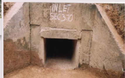
Laluan masuk/keluar pembetung yang bersih akan membenarkan aliran air masuk/keluar yang lancar.
