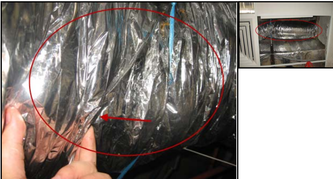
Gambar 4: Menunjukkan terdapat kesan air diantara celah-celah penebat sesalur yang terlipat.
