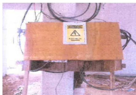
Box Penyambungan Elektrik
