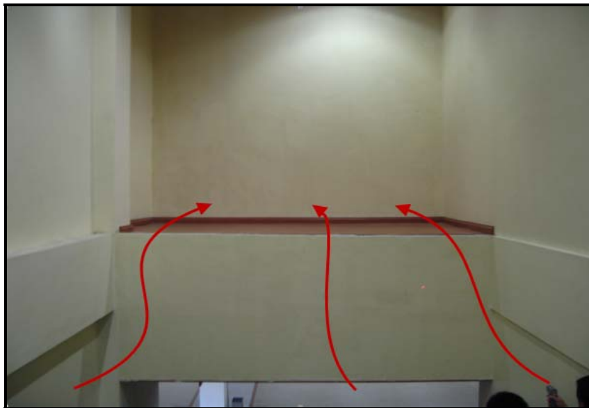
Gambar 10: Rekabentuk pembinaan pada ruang tangga balai ketibaan menyumbang kepada pembentukan fenomena udara mati.
