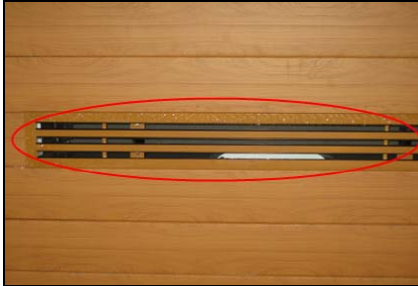
Gambar 7: Didapati linear diffuser mengalami kondensasi di laluan pertukaran ( transfer corridor ) balai ketibaan domestik aras 1.
