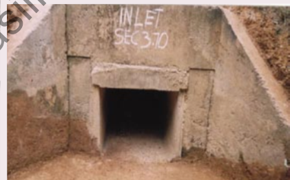
Gambarfoto : Laluan masuk/keluar pembetung yang bersih akan membenarkan aliran air masuk/keluar yang lancar.
