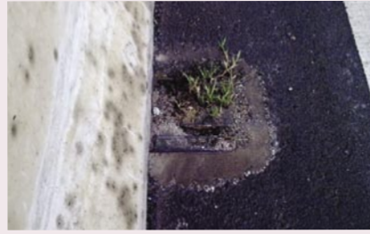
Gambarfoto : Lubang salur air (weep holes) yang tersumbat akibat tumbuhan liar.
