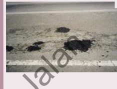
Tetapi dibenarkan untuk sementara waktu : - Hari hujan - Tiada bekalan asphalt campuran panas - Perlu ditampal dengan sempurna selepas situasi di atas di atasi
