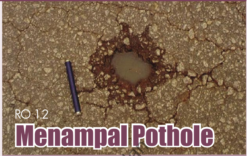
Kawasan sekeliling pothole dipotong sebanyak 150 mm daripada sisi pothole dan membentuk segiempat menggunakan pemotong pavemen.
