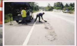
Tetapi dibenarkan untuk sementara waktu : - Hari hujan - Tiada bekalan asphalt campuran panas - Perlu ditampal dengan sempurna selepas situasi di atas di atasi
