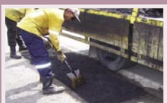
Lebihan tack coat hendaklah dikeringkan untuk mengelakkan lelehan / bleeding.
