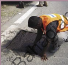
Lebihan tack coat hendaklah dikeringkan untuk mengelakkan lelehan / bleeding.
