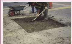
Kawasan sekeliling pothole dipotong sebanyak 150 mm daripada sisi pothole dan membentuk segiempat menggunakan pemotong pavemen.
