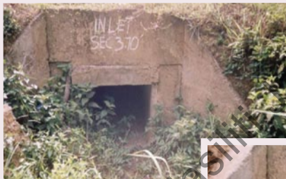
Gambarfoto : Laluan masuk/keluar pembetung yang bersih akan membenarkan aliran air masuk/keluar yang lancar.
