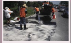
Turunan aktiviti 'crack sealing secara flooding' yang tidak dibenarkan.
