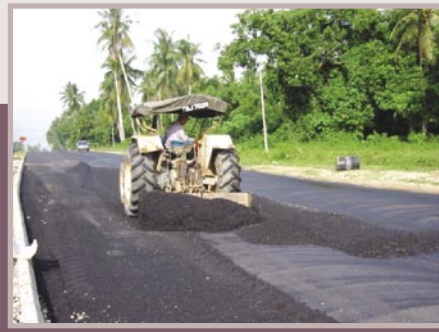
Backpusher tidak boleh digunakan sebagai alternatif kepada mesin penurap.
