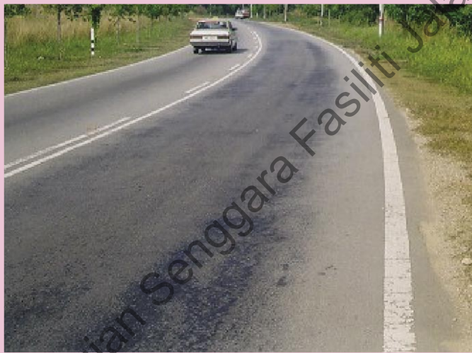
Bleeding adalah petunjuk kandungan bitumen yang berlebihan yang boleh memberi kesan ke atas rintangan gelinciran dan kestabilan permukaan jalan.
