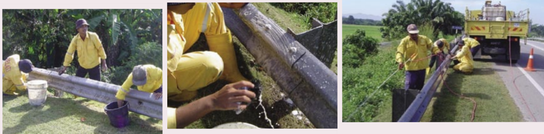
Gambarajah menunjukkan kerja-kerja membersihkan penghadang jalan dilakukan.
