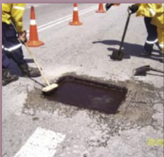
Lebihan tack coat hendaklah dikeringkan untuk mengelakkan lelehan / bleeding.
