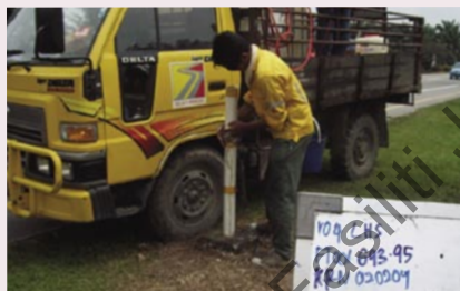
Gambarajah menunjukkan kerja-kerja membersihkan delineator post dan kilometer post dilakukan dan hasilnya.
