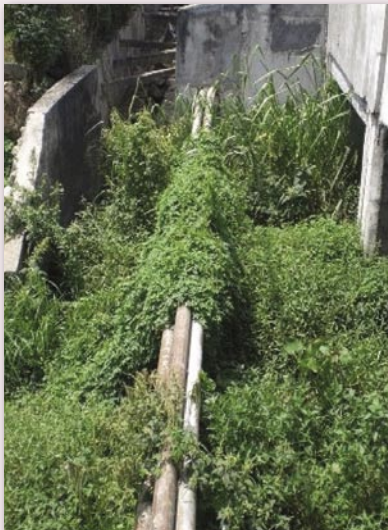
Gambarfoto : Bukaan pembetung yang dipenuhi tumbuhan mampu menghalang kelancaran aliran air masuk/keluar pembetung.
