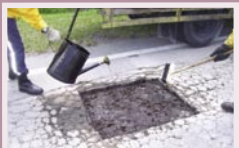
Semburan tack coat rata dan seragam dalam julat 0.25 hingga 0.55 liter/m 2 .
