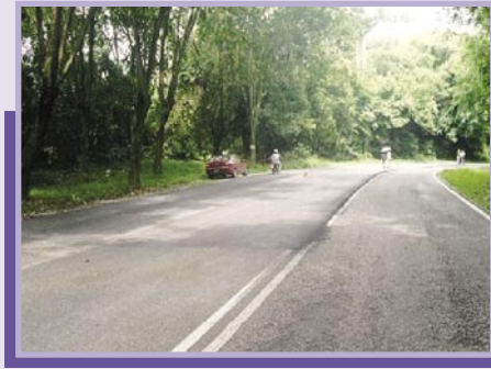
Pengikisan permukaan jalan di lorong sebelah kanan jalan.
