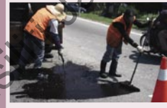
Turunan aktiviti 'crack sealing secara flooding' yang tidak dibenarkan.
